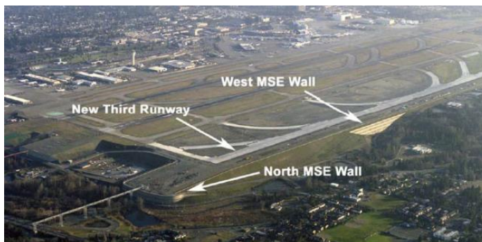
شکل ۳-۴: دیوار MSE حاشیه غربی باند فرودگاه سیاتل تاکوما [۲۱]
