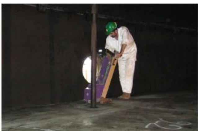
شکل 1-6 : آزمون ورق های کف مخزن با دستگاه FloorMapVS2i
