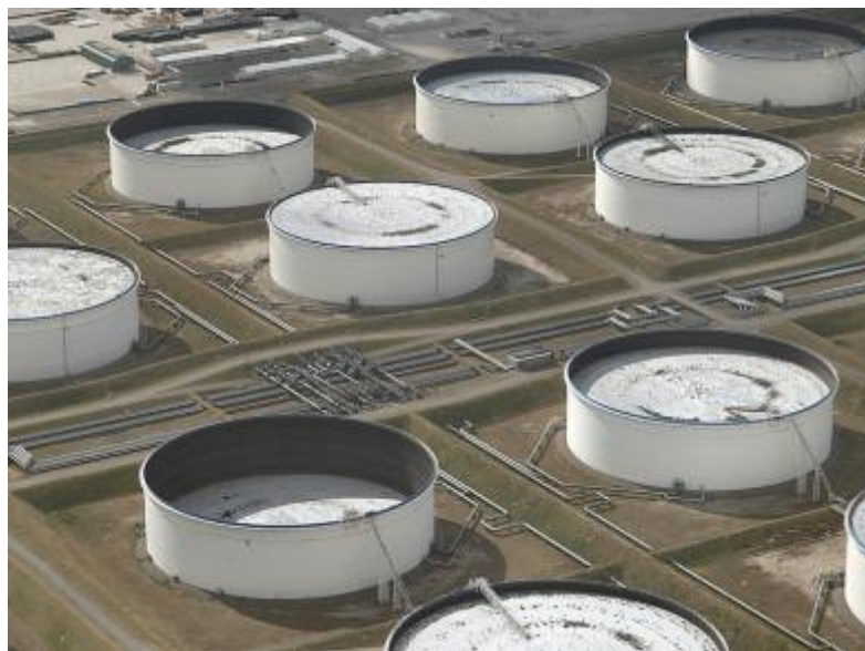
شکل 5-2 مخازن سقف شناور خارجی
