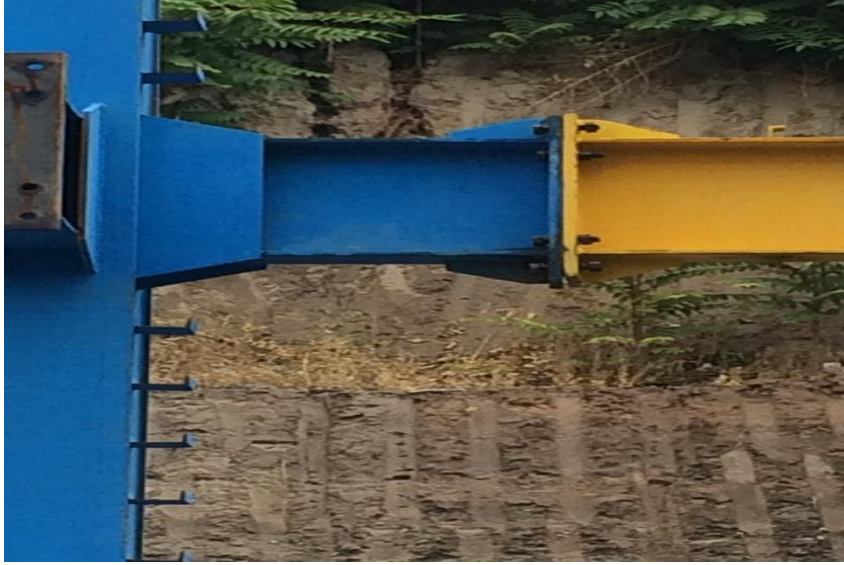
شکل ۱-۱۰-۱- روش‌های افزایش سختی اتصال خمشی با ورق کناری
