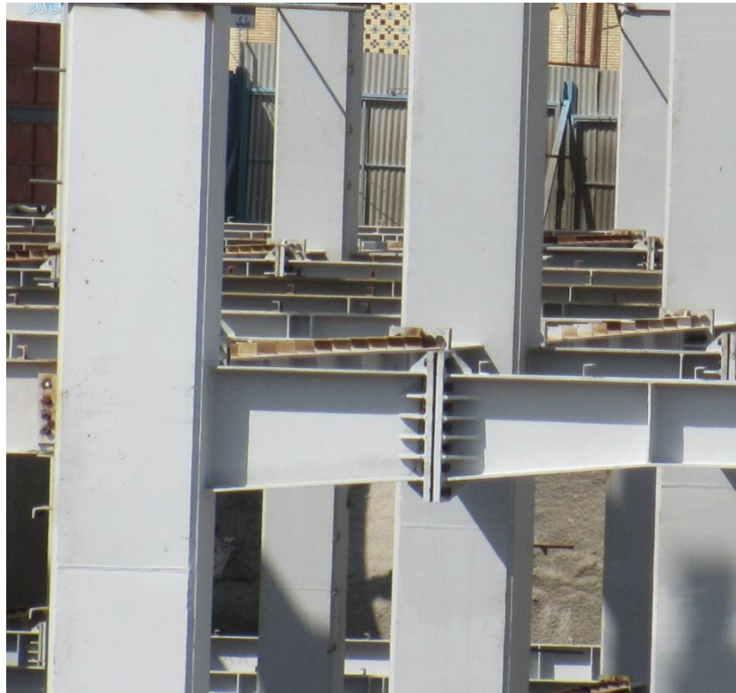
شکل ۱-۱۱-۱- روش‌های افزایش سختی اتصال خمشی با منشوری کردن جان
