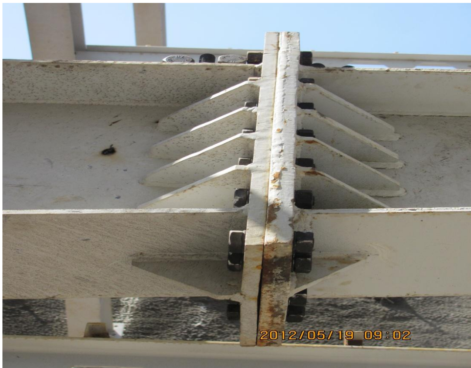
شکل ۴-۱- اتصال تیر ریشه به تیر اصلی با اتصال فلنجی
