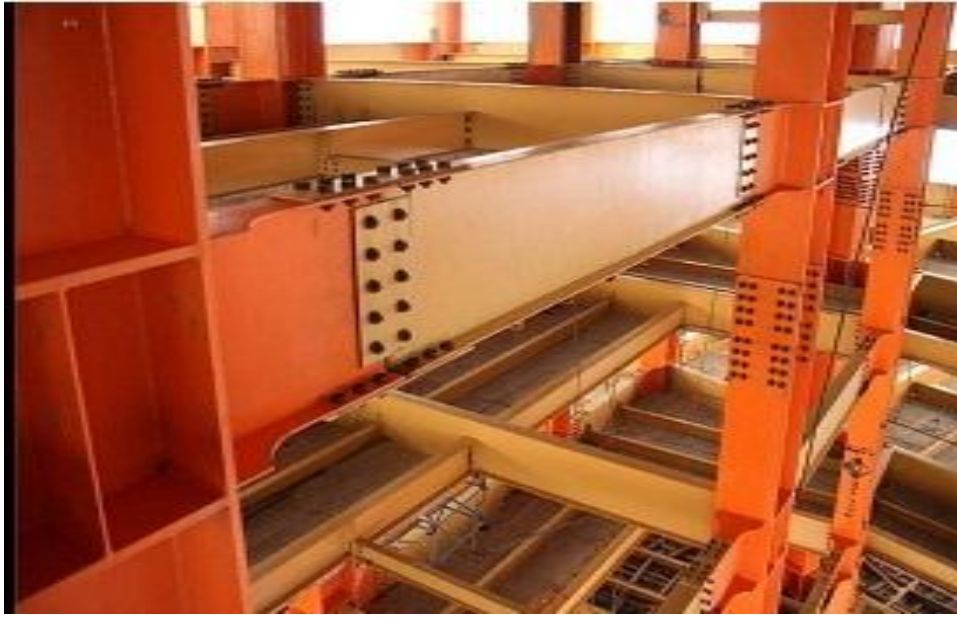
شکل ۱-۱۲- روش‌های افزایش سختی اتصال خمشی با عریض کرده ورق بال و منشوری کردن ورق بال
