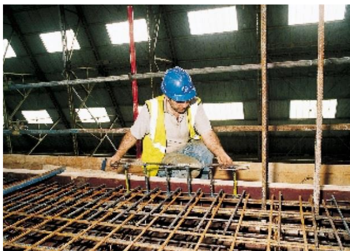
شکل (۲-۱۴) گل‌میخ برشی AncoPLUS[7]
