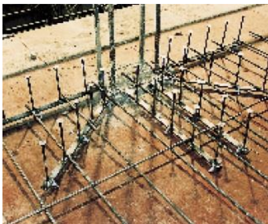
شکل (۲-۱۳) نحوه قرارگیری گل‌میخ برشی DEHA در یک ستون کناری [7]
