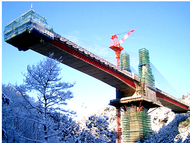
شکل (۷-۲): نمایی از پل در حال ساخت دارای مقطع صندوقه‌ای مرکب با جان فولادی موج‌دار
