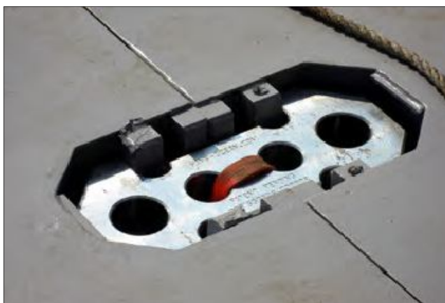
شکل (۳۳-۲) نمونه‌ای از اتصال صلب بین قطعات پانتونی
