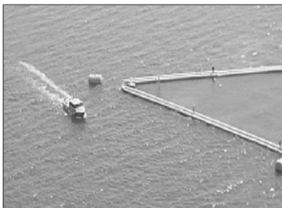
شکل (۸-۱) موج‌شکن شناور سریع‌النصب (RIBS)
