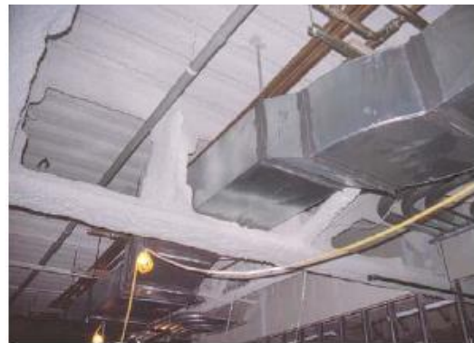
شکل ۵-۱. عبور تاسیسات از میان جان قاب خمشی خرپایی
