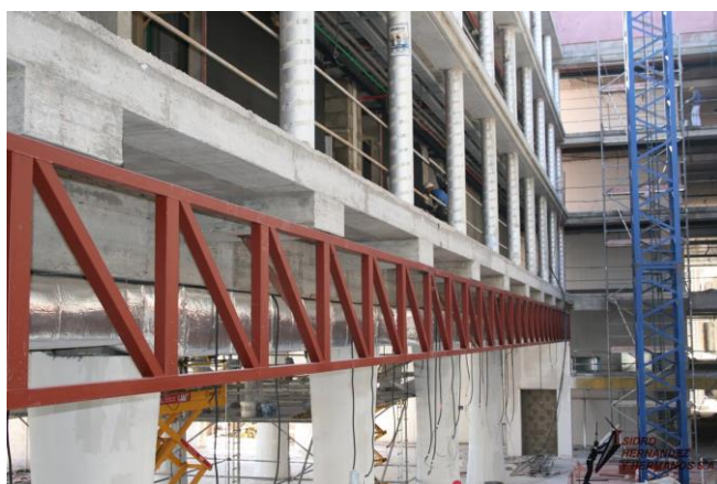
شکل ۵-۳. نمونه ای از قاب با تیر خرپایی معمولی (وارن)
