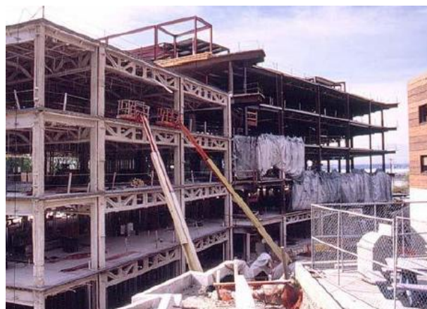
شکل ۵-۴. قاب های خمشی با تیرهای خرپایی ویژه (STMF)
