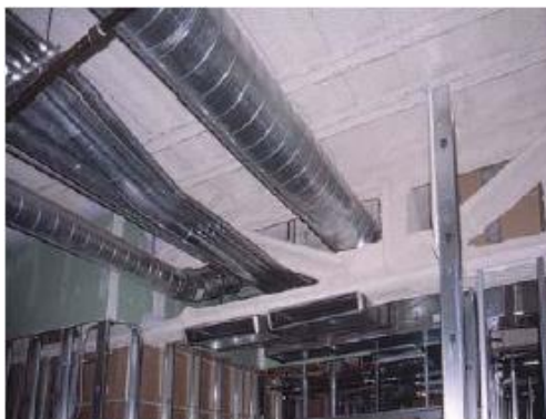
شکل ۵-۱. عبور تاسیسات از میان جان قاب خمشی خرپایی
