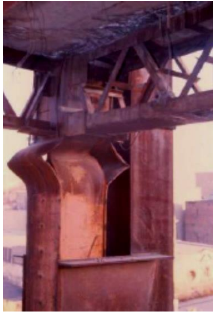
شکل ۵-۲. تشکیل مفصل پلاستیک در ستون قاب خرابایی معمولی
