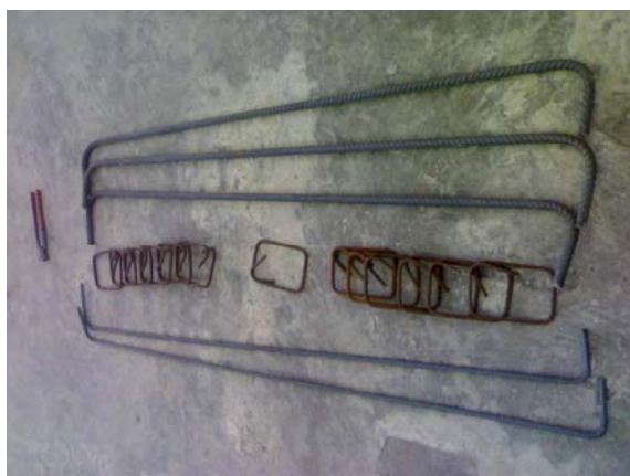
شکل ۳-۱۴ آرماتور بندی تیرها
