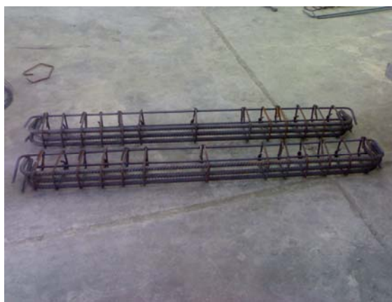
شکل ۳-۱۴ آرماتور بندی تیرها
