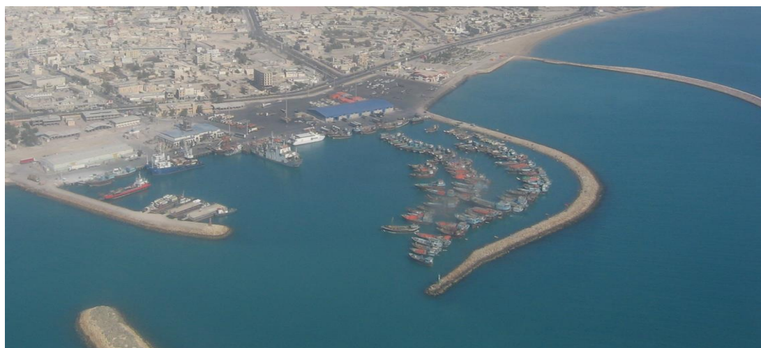
شکل ۴-۱- موقعیت قرارگیری اسکله قدیمی و نمای کلی از اسکله بندر لنگه
