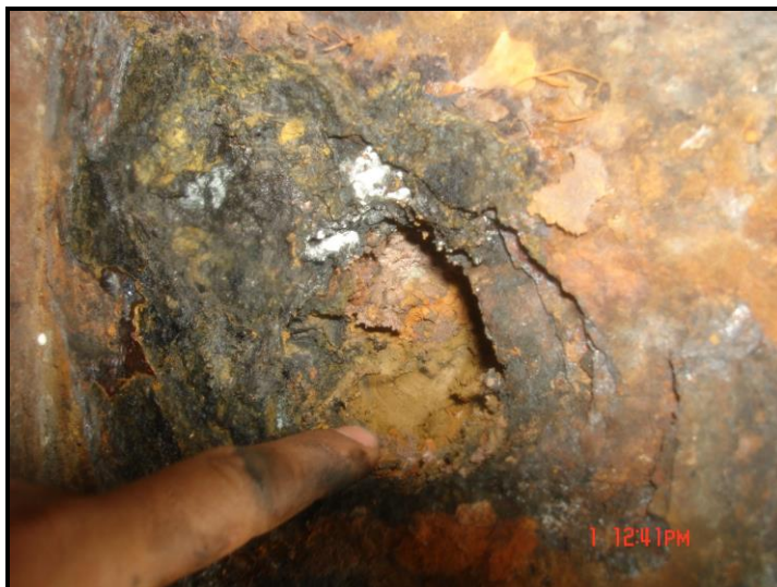
شکل ۴-۴- خوردگی کامل شیت پایل در بعضی از نواحی پاشش آب
