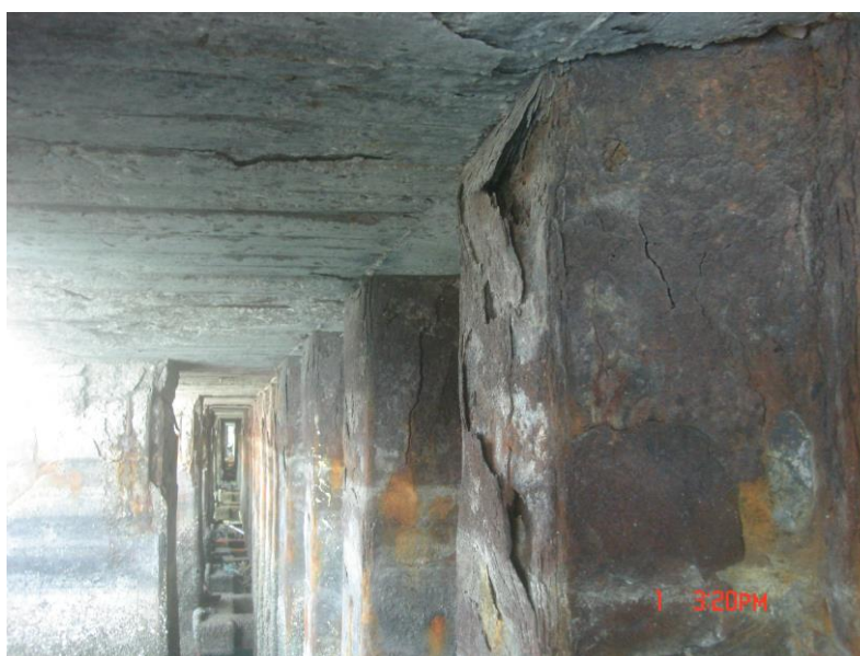
شکل ۴-۳- نمایی از سپر خورده شده
