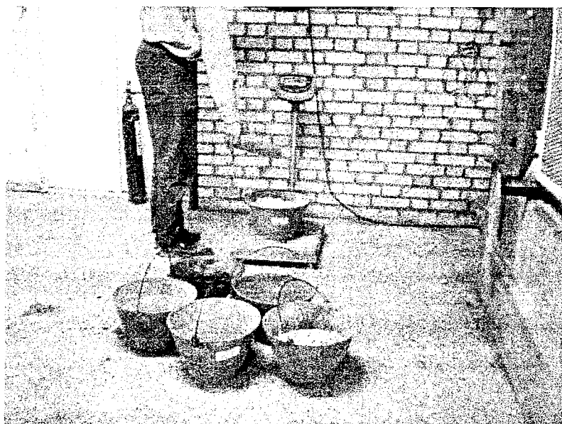
ت ۱۱- توزین مصالح جهت ساخت بتن
