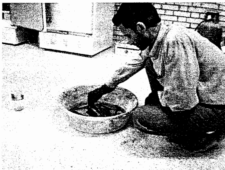
ت ۴۰- زنگ زدایی میلگردها به وسیله اسید سولفوریک با غلظت ۱۰ درصد
