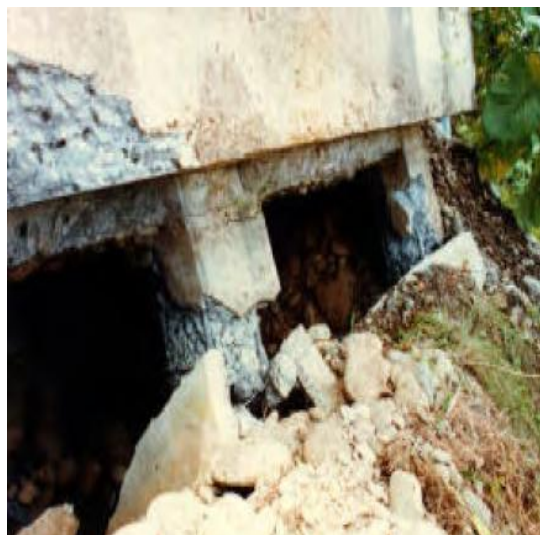
شکل (پ ۱-۲): نمونه هایی از خرابی شمع های اسکله ها در اثر زلزله کاستاریکا [۷۱]
