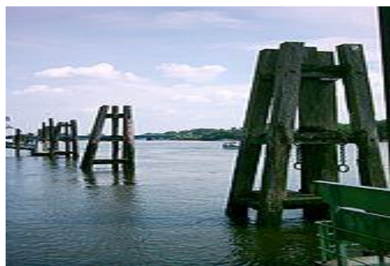
شکل (۲۱-۲): دلفین با شمع مایل
