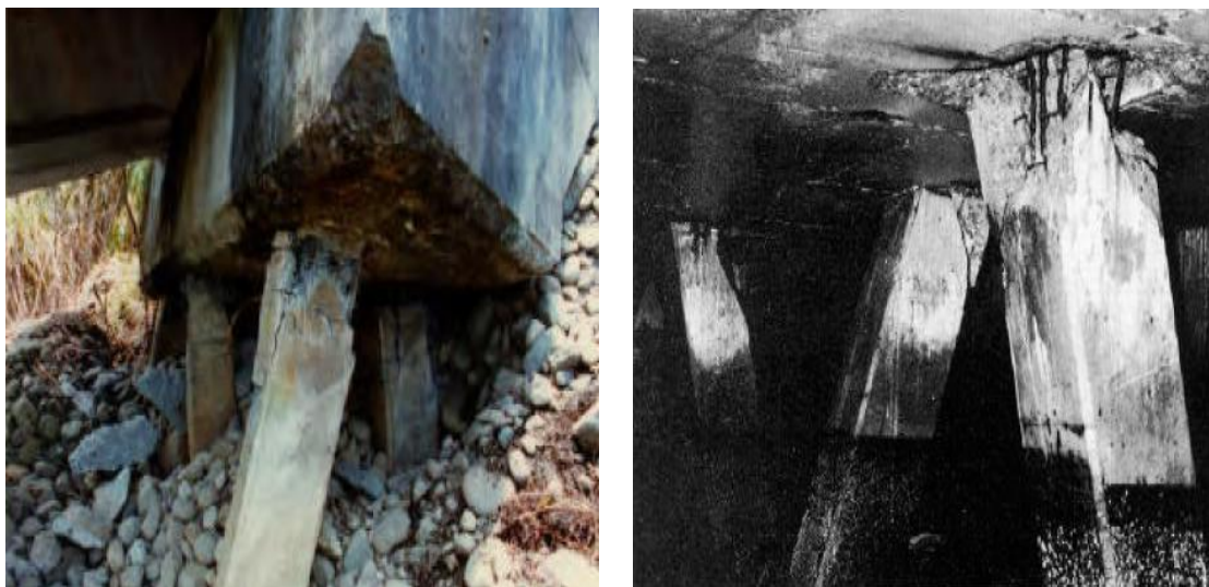
شکل (۲-۲۵): نمونه هایی از خرابی شمع های مایل اسکله ها در اثر زلزله
