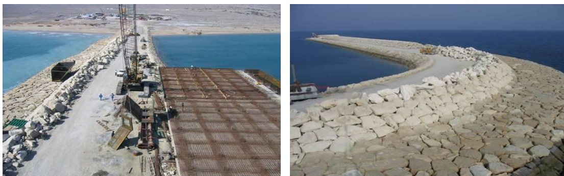
شکل (۱-۱): نمونه هایی از موج شکن و احداث اسکله در مجاورت آن
