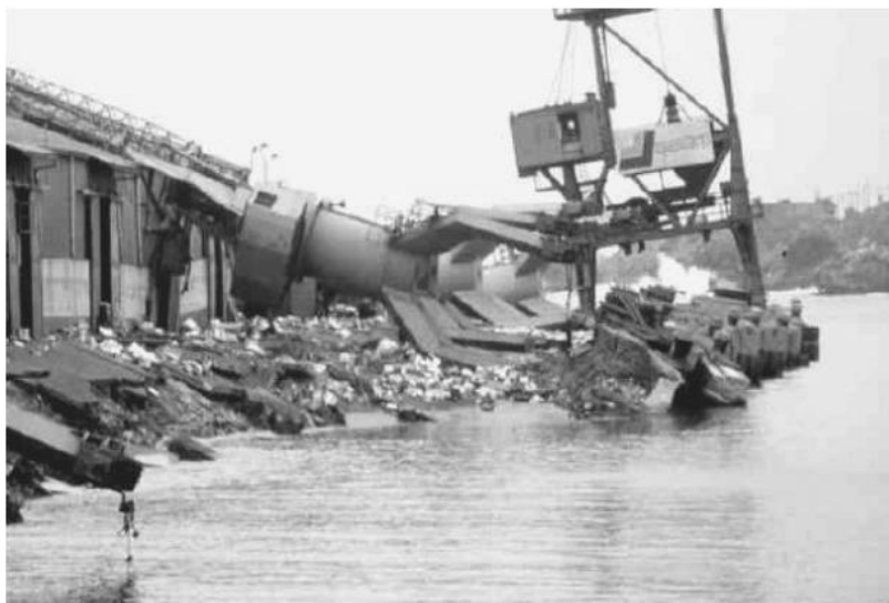
شکل (پ ۱-۴): خرابی اسکله و جرثقیل آن در زلزله ترکیه [۱]
