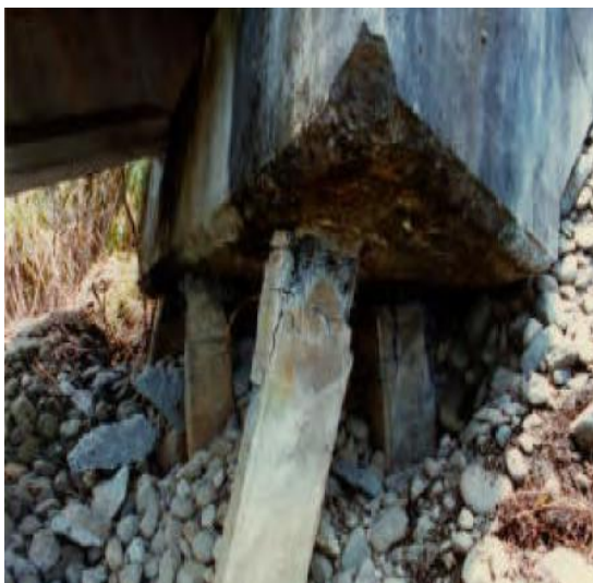
شکل (پ ۱-۲): نمونه هایی از خرابی شمع های اسکله ها در اثر زلزله کاستاریکا [۷۱]
