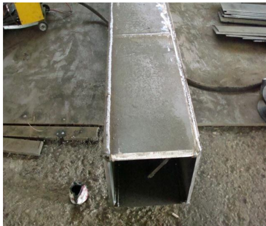
(۴) اجرای جوش درپوش به ادامه ورق
