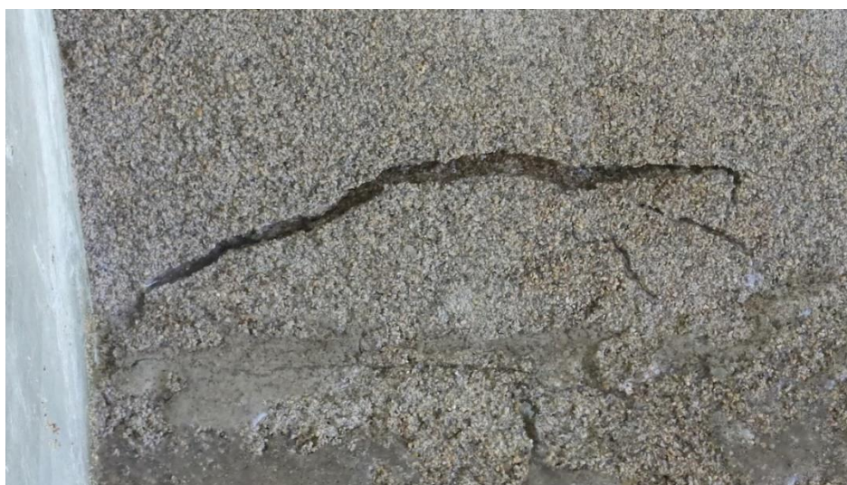
شکل ۴-۴۲ گسیختگی پوشش ۵٪ نانو آهک هیدراته
