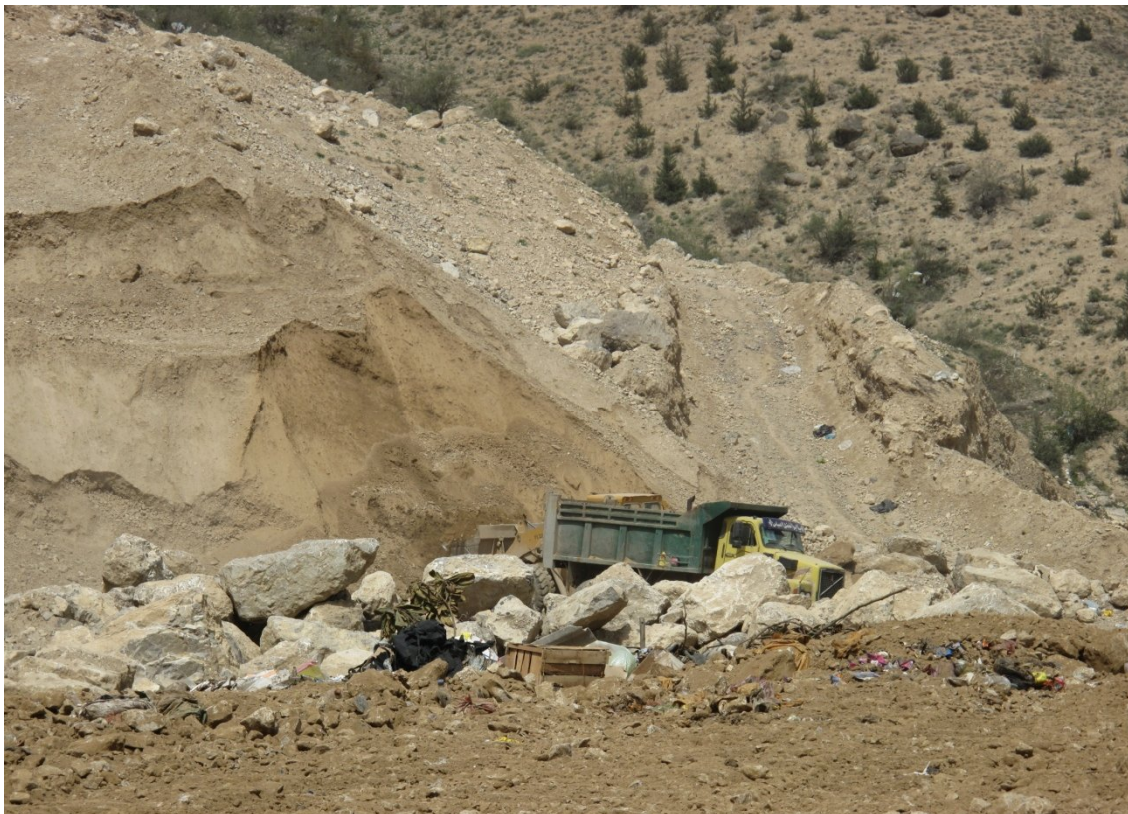
شکل ۳-۳. برداشت خاک و سنگ از اطراف منطقه دفن برای خاک پوششی
