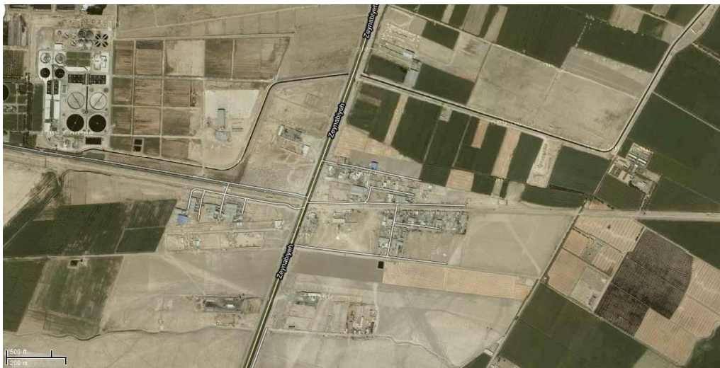
شکل ۳-۲- تصفیه‌خانه فاضلاب شمال اصفهان و مزارع اطراف آن
