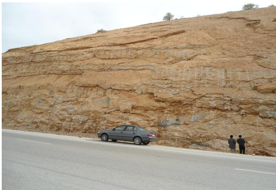
شکل (۳-۱۸) - احتمال خطر ریزش‌های بلوکی و صفحه‌ای (در صورت وقوع زمین‌لرزه) در سازند آسماری-شهبازان (ایستگاه شماره ۸)
