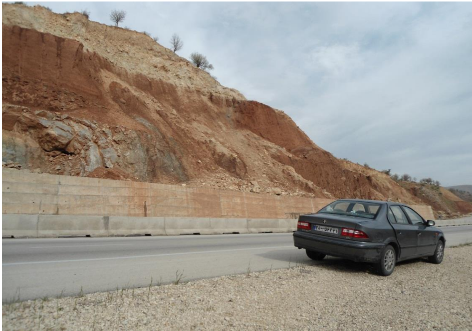
شکل (۳-۱۷) - ریزش و لغزش در سازند گچساران با لایه‌های کاملاً به هم ریخته (ایستگاه شماره ۷)
