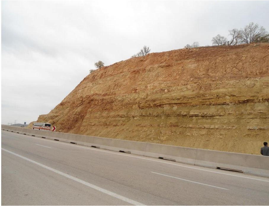
شکل (۳-۱۹) - سازند آسماری بر اثر رانندگی بر روی سازند گورپی قرار گرفته است. در این نقطه ریزش‌های بلوکی به دلیل وجود درزه‌هایی با شیب ۹۰ درجه رخ داده است (ایستگاه شماره ۹).
