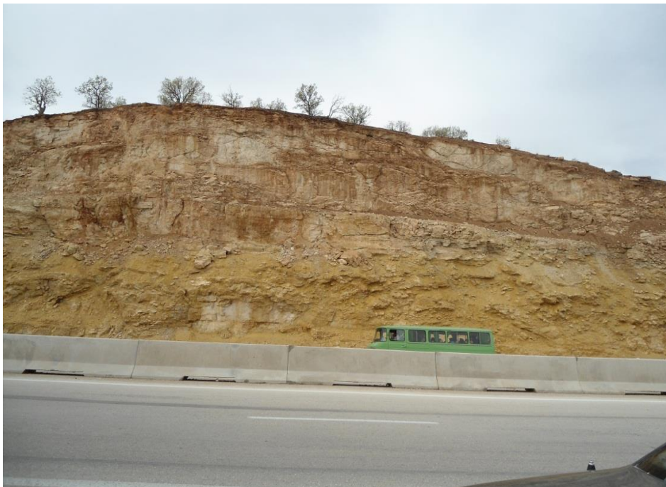
شکل (۳-۲۰) - خطر ریزش‌های سنگی در سازند آسماری (ایستگاه شماره ۱۰)
