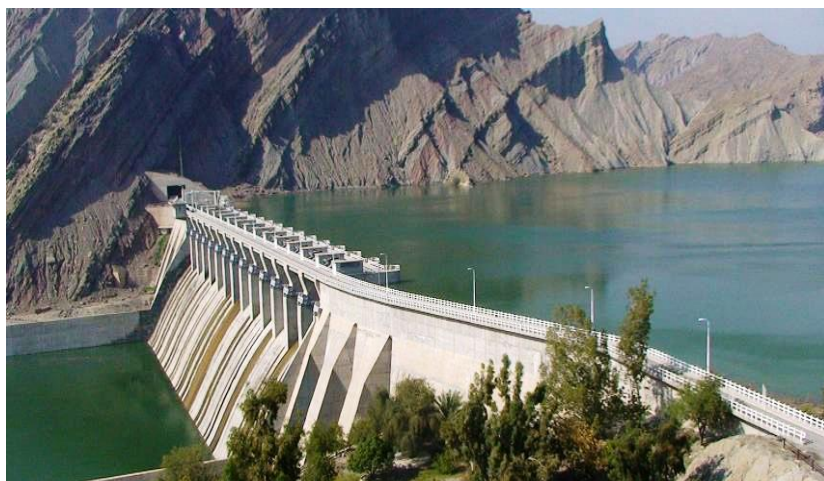
شکل ۴-۱- نمایی از سد میناب و موقعیت لایه‌های ماسه‌سنگی نسبت به جهت جریان.
