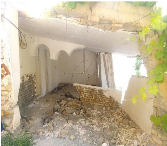
شکل ۱-۱: ترک‌های ایجاد شده و تخریب منازل مسکونی روستای تلوبین ناشی از رخداد زمین لغزش
