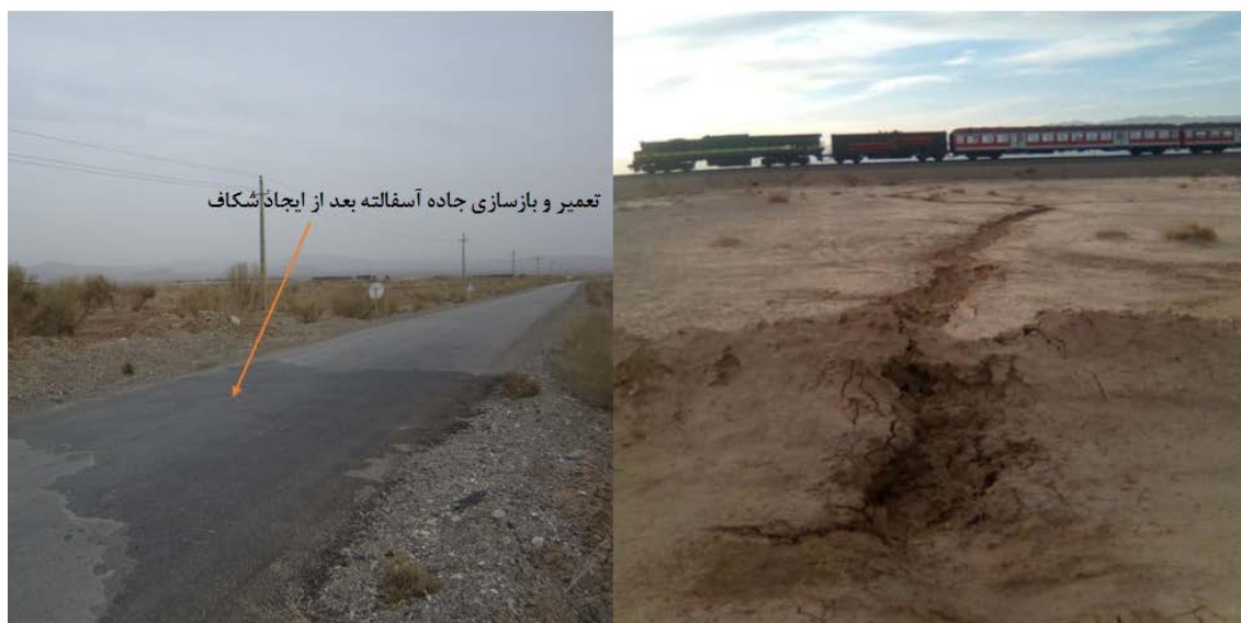
شکل ۱-۲: نمایی از شکاف‌های ایجاد شده در اطراف راه آهن سراسری تهران - مشهد و جاده آسفالتی مجاور آن
