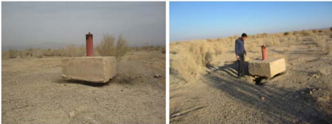
شکل ۴-۹: تصاویری از بیرون زدگی لوله جدار پیزومترها در شرق اعلا
