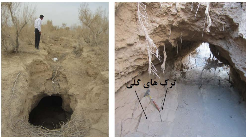
شکل ۴-۱۵: تصاویری از تونل‌های پایپینگ ایجاد شده در محل شکاف‌ها در دشت سمنان
