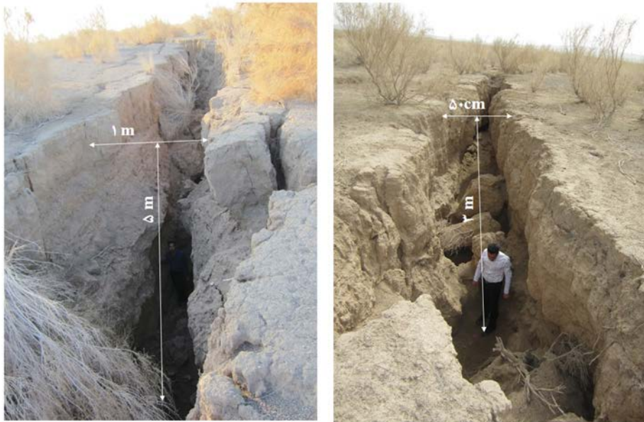
شکل ۴-۱۴: تصاویری از رخداد شکاف در دشت سمنان
