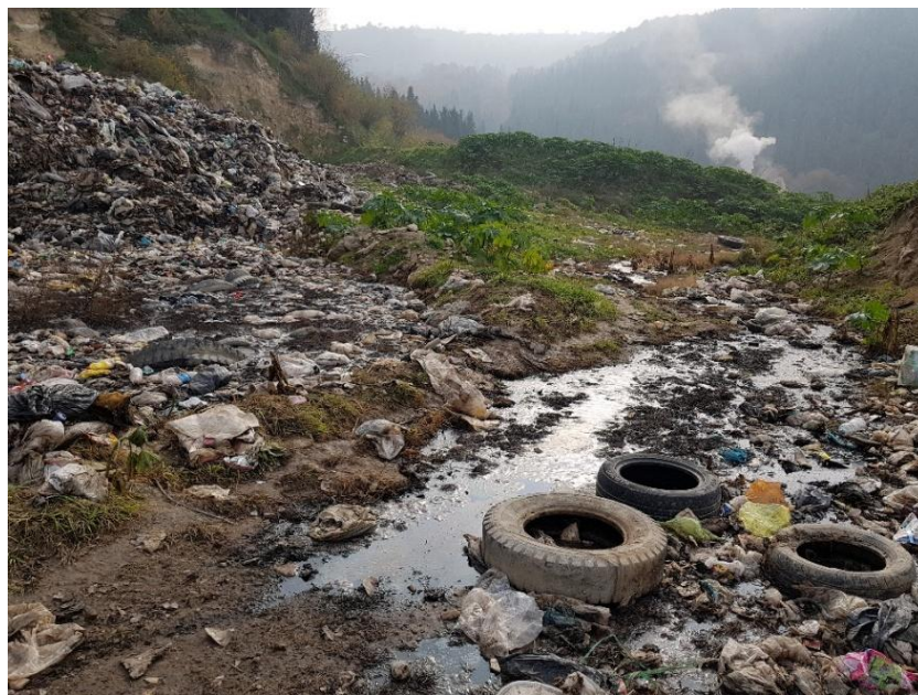
شکل ۱-۲- دفع زباله و جاری بودن شیرابه تولیدی از آن در لندفیل بهشهر
