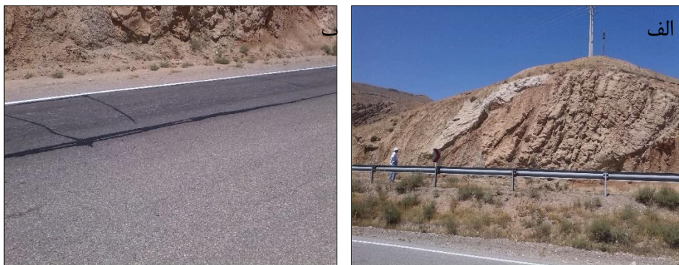
(شکل ۳-۱۲) الف: تصویر صحرایی از پهنه برشی. ب: شکستگی های سطح جاده ی آسفالت
