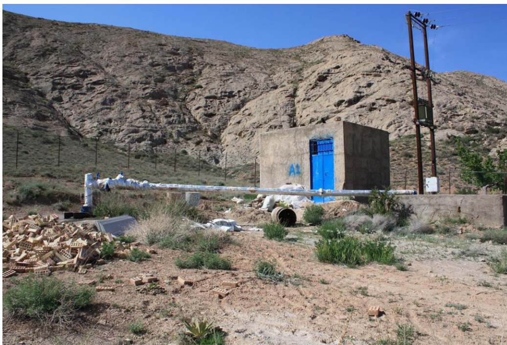
شکل ۱-۶- چاه حفر شده در سازندهای آهکی
