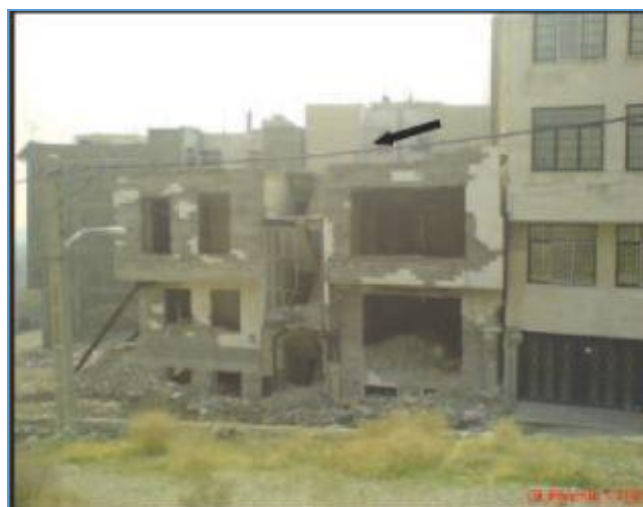
شکل ۱-۱۴: منازل تخریب شده در اثر لغزش در شهرک مجلس (صفاری و مقیمی، ۱۳۸۷)
