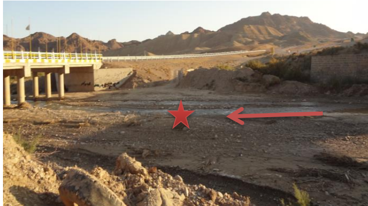
شکل (۴-۱۶): ایستگاه هیجدهم، زیر پل، دید از شمال شرق
