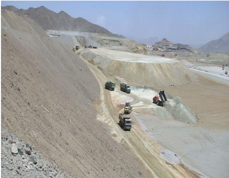
شکل ۱-۲۱- نمایی از خاکریزی بر روی بستر آماده شده
