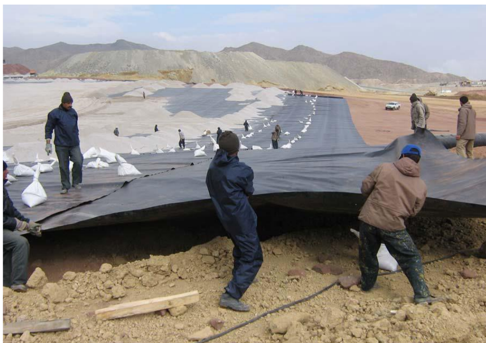
شکل ۸-۱- عملیات پهن کردن لاینر
