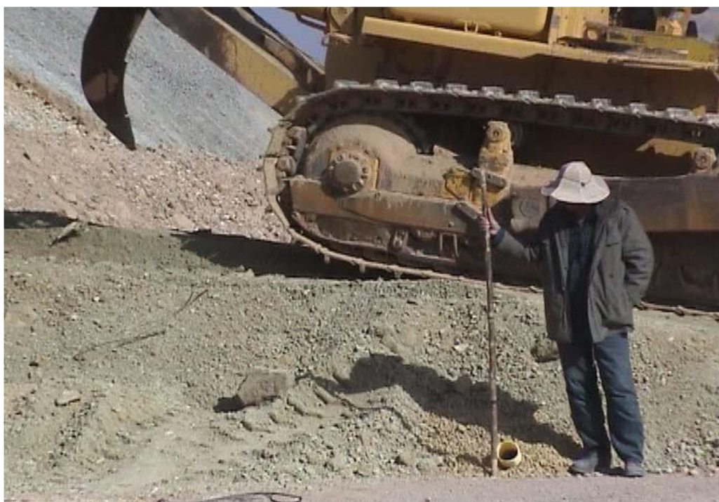
شکل ۱-۱۶- عملیات تست لوله‌های زهکش
