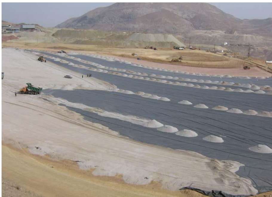
شکل ۱-۱۲- نمایی از عملیات کوشین‌ریزی و تسطیح آن
