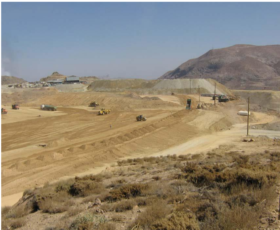
شکل ۱-۱۷- نمایی از عملیات خاکریزی جهت ساخت جاده‌های در دسترس
