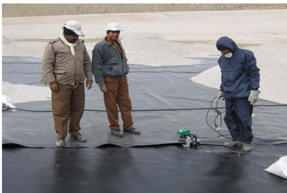
شکل ۹-۱- عملیات جوشکاری لاینرها
