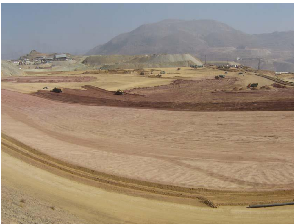
شکل ۱-۷- نمای از عملیات رس‌ریزی، تسطیح و مرطوب نمودن آن
