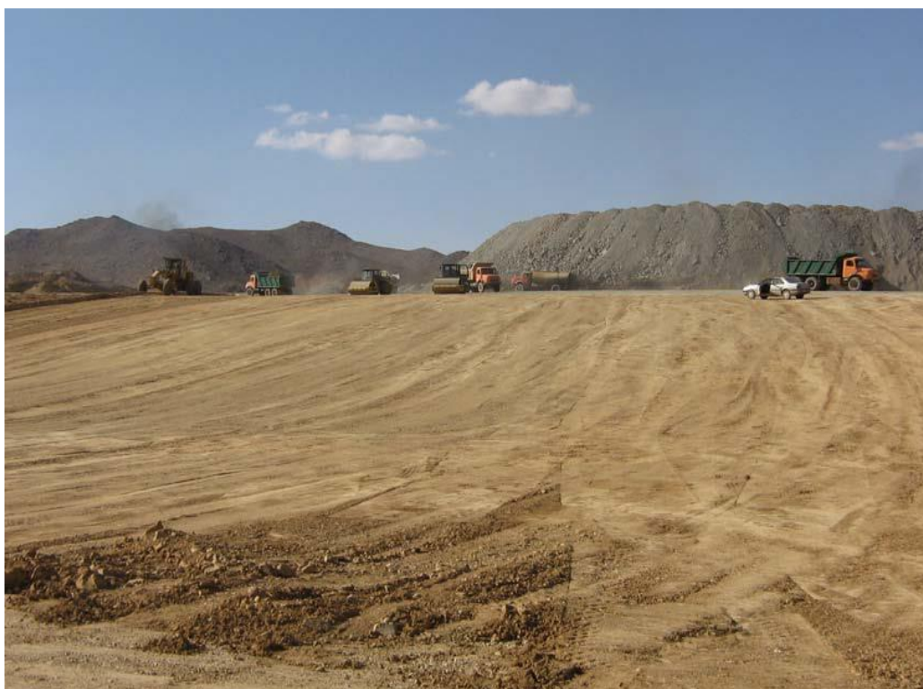
شکل ۱-۶- تصویری از عملیات تسطیح و کوبیده‌شدن بستر
