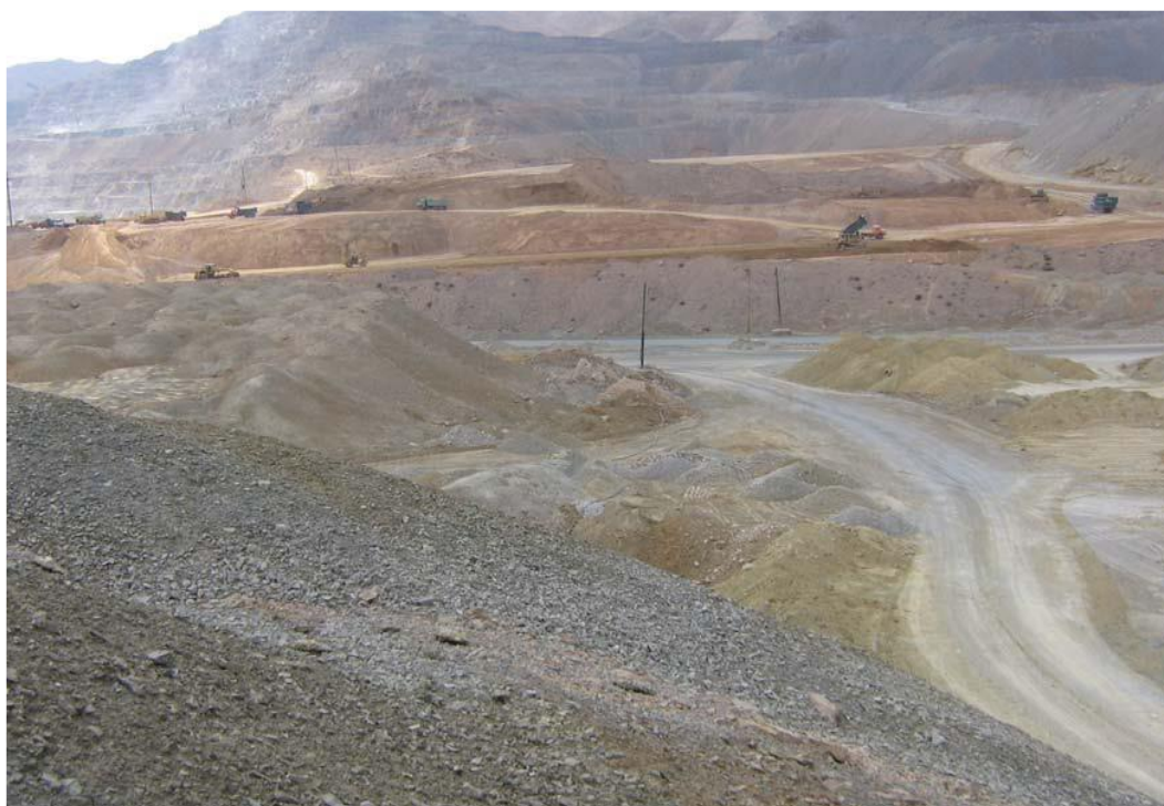
شکل ۵-۱- نمایی از خاکبرداری از نقاط مرتفع تر و پرکردن نقاط پست تر
