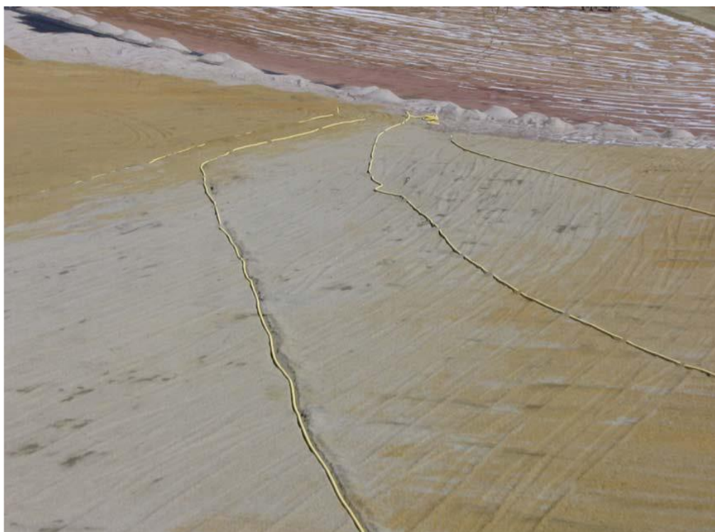
شکل ۱-۱۵- عملیات لوله‌گذاری لوله‌های زهکش
