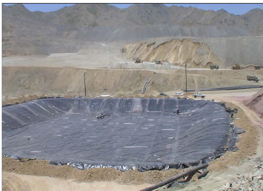
شکل ۲۳-۱- نمایی از استخر آماده شده رافینیت
