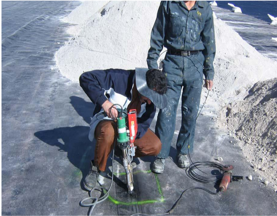
شکل ۱-۱۰- عملیات درزگیری لاینرها
