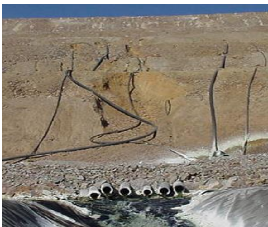
شکل ۴-۵- فرسایش بدنه هیپ در اثر خروج سیال از بخشهای میانی آن
