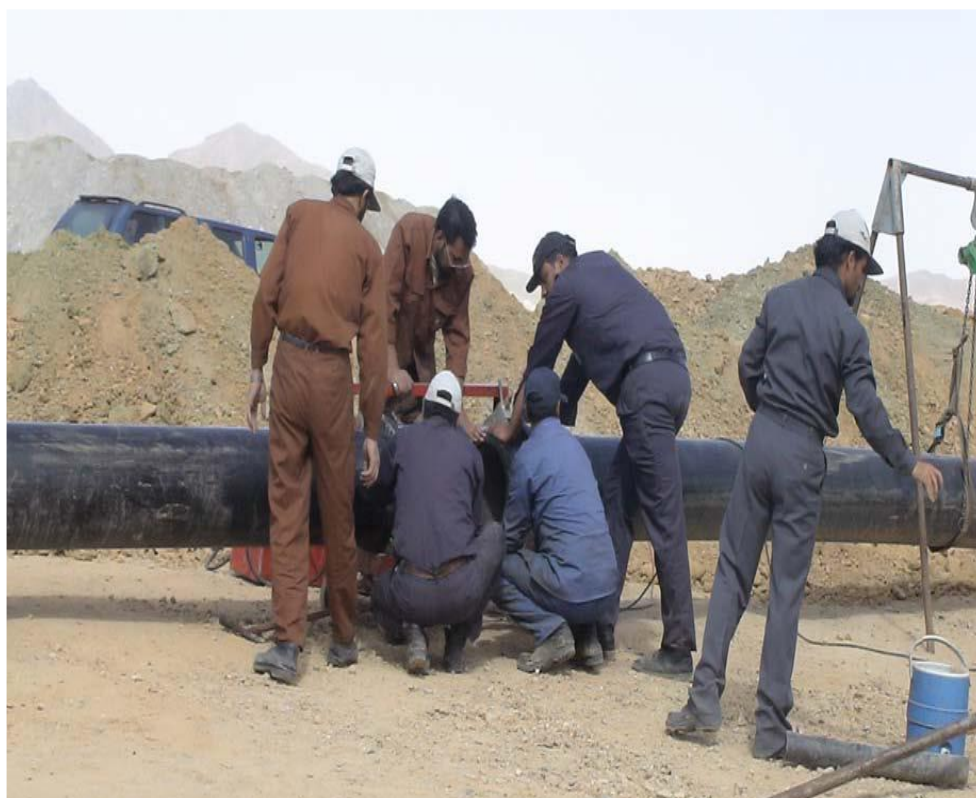
شکل ۱-۲۰- تصویری از جوشکاری لوله‌های به قطر ۴۰ سانتی‌متر
