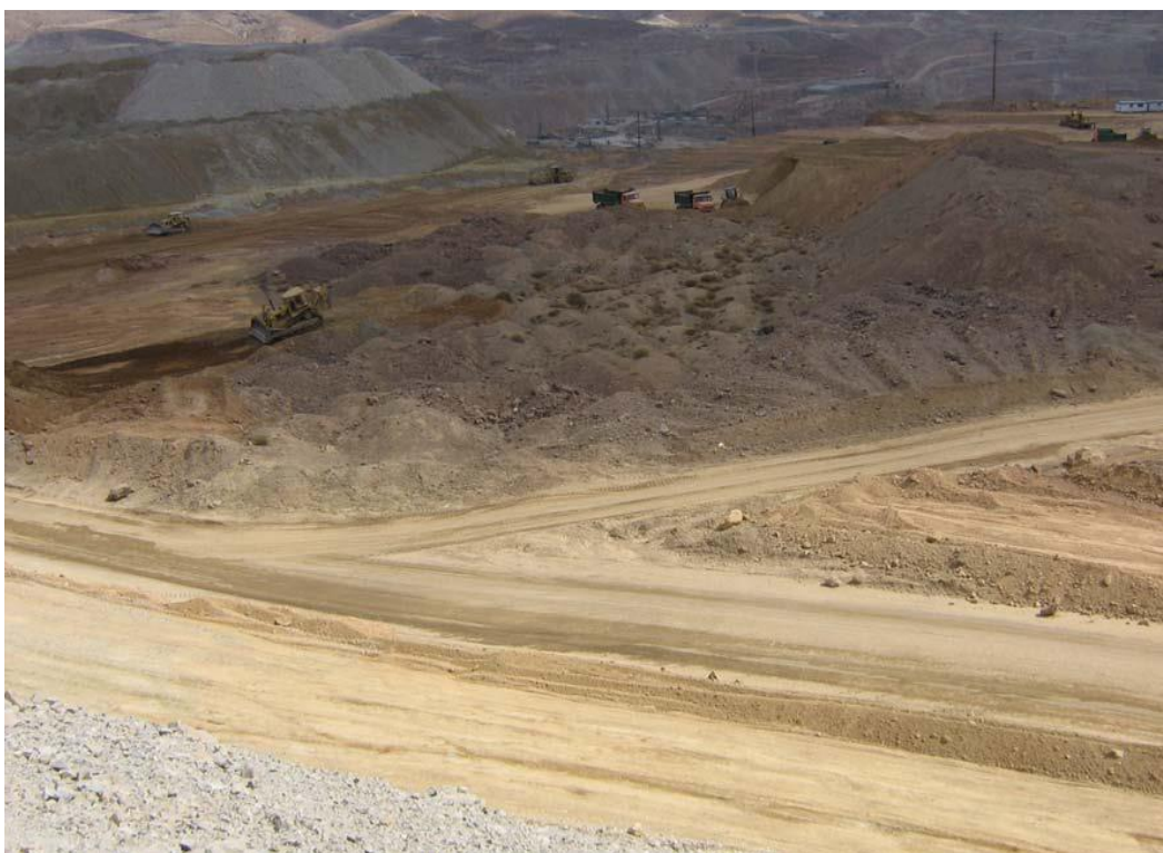
شکل ۴-۱- تصویری از عملیات خاکبرداری از نقاط مرتفع هیپ
