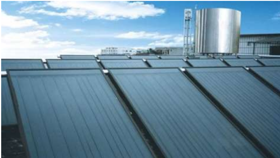
شکل ۱-۱: شماتیکی از یک کلکتور صفحه تخت
