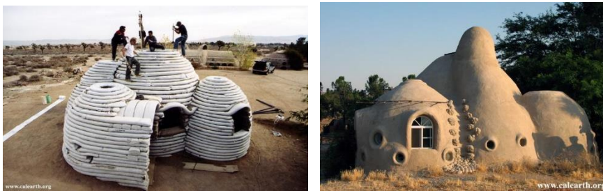
تصویر ۲-۹- تصاویری از خانه سازی نادر خلیلی به روش سیستم ابرخشت (Serageldin, 2007, 83)
