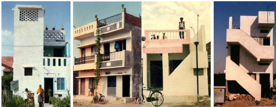
تصویر ۳-۳۷- نمونه ای از ناهماهنگی در طراحی ناشی از سلیقه شخصی استفاده کنندگان در ساختمان های شهرک آرانیا (Doshi, 1989, 15)
