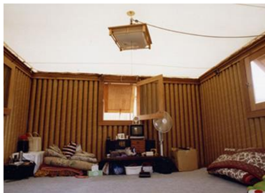
شکل ۶-۲۵: پناهگاه‌های ساخته‌شده با سیستم لوله‌های کاغذی، (Ban, 2010)
