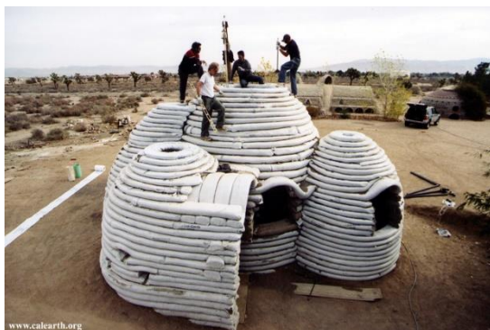
شکل ۶-۲۴: ساخت پناهگاه با استفاده از سیستم ابر خشت، (Cal-Earth Institute, 1992)
