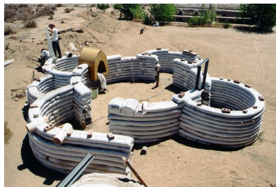
شکل ۶-۲۴: ساخت پناهگاه با استفاده از سیستم ابر خشت، (Cal-Earth Institute, 1992)
