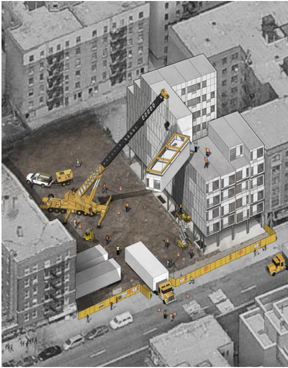
تصویر (۳-۲۹) تصویر شماتیک از نحوه قرارگیری و نصب مدول‌ها [۳۹]
