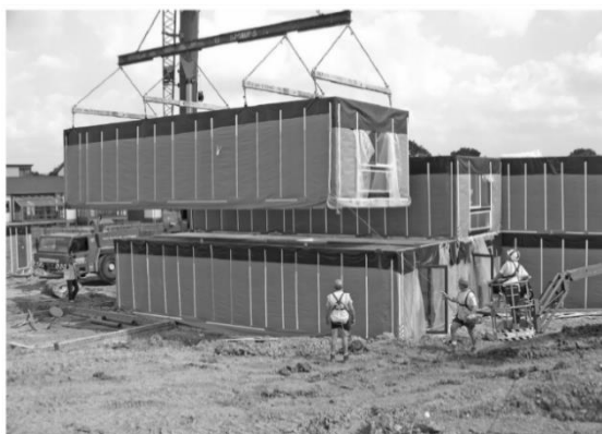
تصویر (۴-۳۰) اتصال بالابر به مدول با تیر واسط [۲۷]
