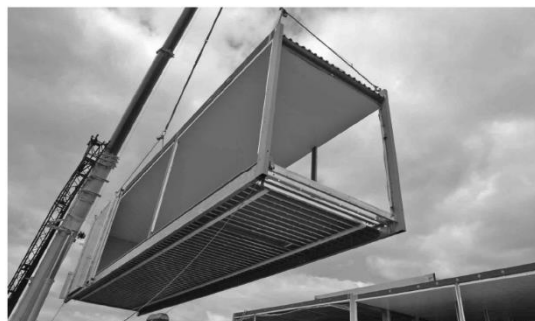
تصویر (۴-۲۸) اتصال بالابر به مدول بدون سازه واسط [۲۷]
