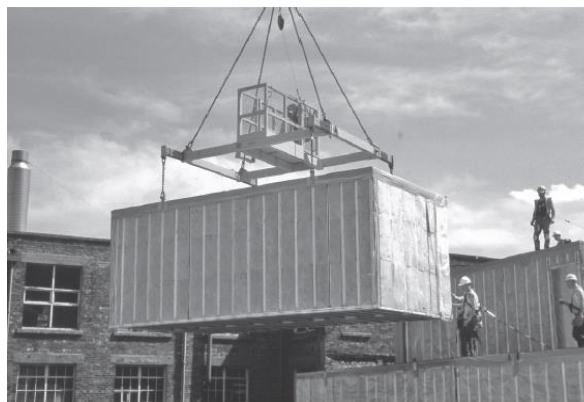
تصویر (۴-۲۹) اتصال بالابر به مدول با قاب واسط [۲۷]
