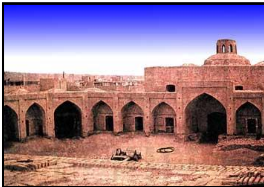
تصویر ۴۵-۶: نمای حیاط مرکزی و اطاق های کاروانسرا باغ شیخ، ورودی اصطبل در سمت چپ عکس دیده می شود. کاروانسرا های واقع در دشت های فلات نیز مانند سایر کاروانسرا ها جهت ایمنی همانند یک قلعه ساخته می شدند و غالباً دارای دیوار های بلند و چهار برج در چهار گوشه بنا و یک دروازه حفاظت شده در قسمت ورودی بوده اند. شب ها در کاروانسرا بسته می شده است
