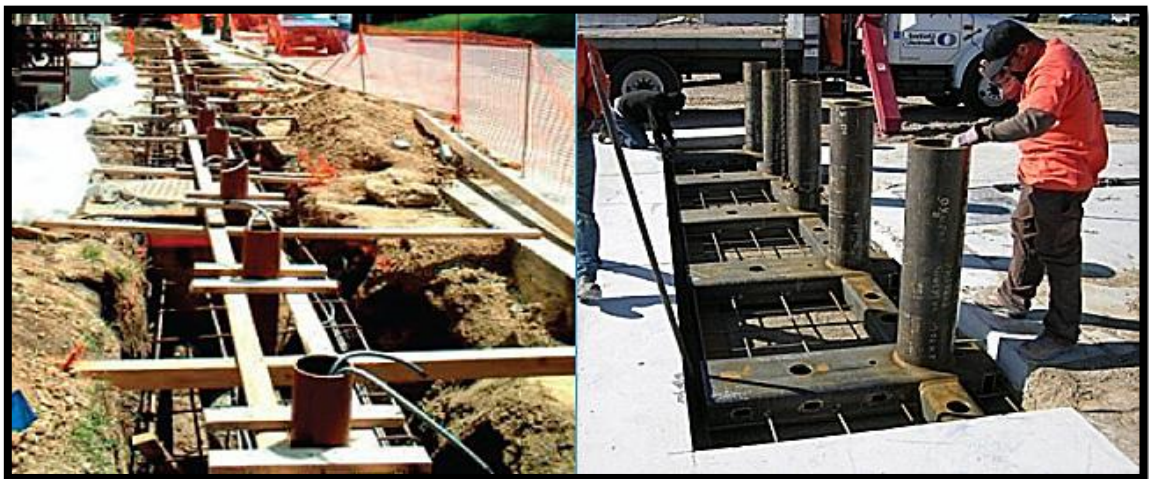
تصاویر ۶-۶ و ۷-۶ موانع محیطی جهت جلوگیری از نفوذ تهدیدات متحرک
