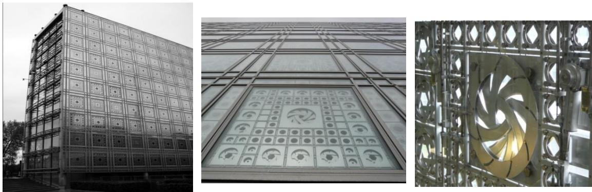
شکل (۶۴-۲) نمای متحرک ساختمان انستیتوی عرب جهت کنترل نور ورودی به فضای داخلی
