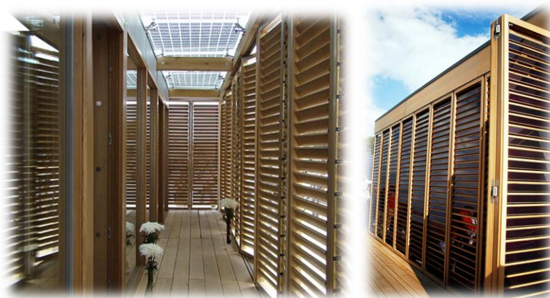
شکل (۶۸-۲) نمای هوشمند شامل لوورهای چوبی خودکار همراه با فتوولتائیک های تلفیق شده با آن
