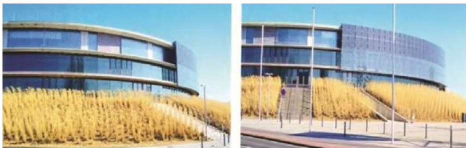
شکل (۶۷-۲) ساختمان EVE با نمای متحرک فتوولتائیک برای تولید انرژی
