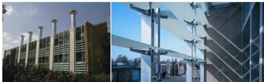
شکل (۶۱-۲) کرکره های قابل تنظیم ساختمان BRE به عنوان نمونه ای از نماهای متحرک هوشمند به همراه پیستون الکتروپنوماتیکی
