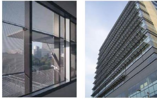
شکل (۶۲-۲) سیستم پیش آمدگی متحرک افقی بر روی نمای ساختمان منطقه ۷ کالترانس
