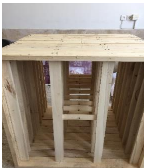
شکل ۳-۱۴ : ۹ عدد قاب چوبی ، ساخته شده جهت نگهداری و تحمل وزن پنل‌های دیوار زنده بروی خود و ایجاد حفره هوا بین پنل‌ها و سطح دیوار
