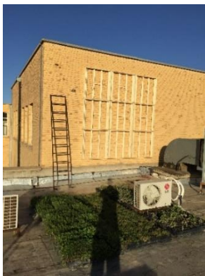
شکل ۳-۱۳ : نصب قاب‌های چوبی نگهدارنده پنل‌های دیوار زنده بروی دیوار
