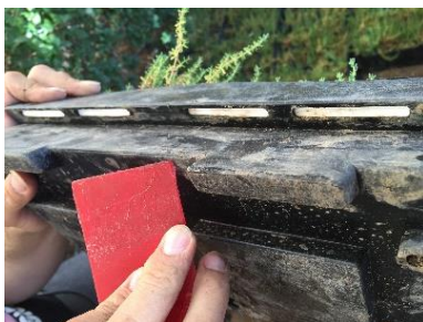
شکل ۳-۲: درز گیری شیار زیری پنل‌ها جهت آب بند کردن آنها تا میزان رطوبت پنل‌ها با هم یکسان باشند.
