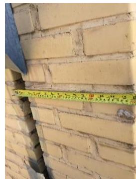
شکل ۱۶-۳: عرض 35 cm دیوار و درز 5 cm بدون عایق بین دیوار مورد نظر و دیوارهای جانبی اتاق مورد آزمایش
