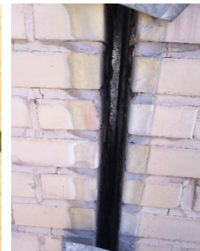
شکل ۱۶-۳: عرض 35 cm دیوار و درز 5 cm بدون عایق بین دیوار مورد نظر و دیوارهای جانبی اتاق مورد آزمایش
