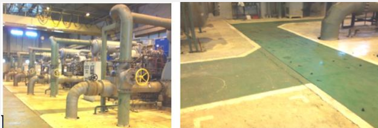
تصویر ۵-۷ شکل طراحی فضاهای تردد و شکل واحد تجهیز شده بعد از اجرای فرایند نگهداری و تعمیرات پیشگیرانه
