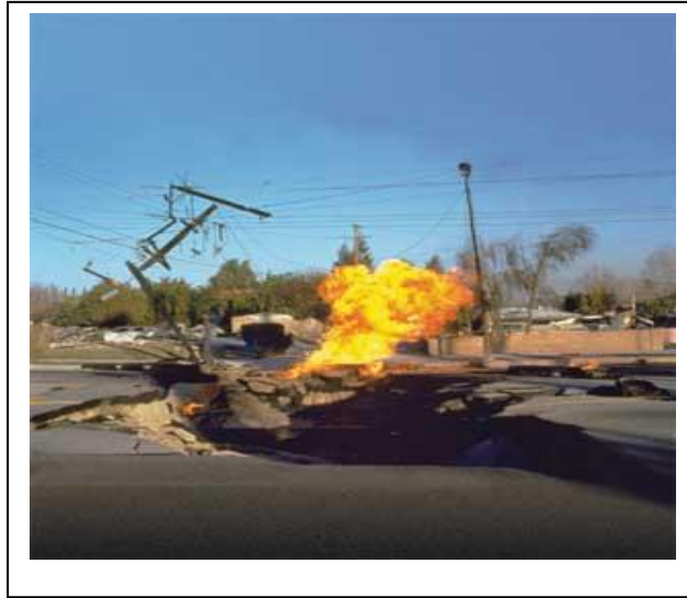
شکل (۱-۳) آسیب به لوله مدفون
