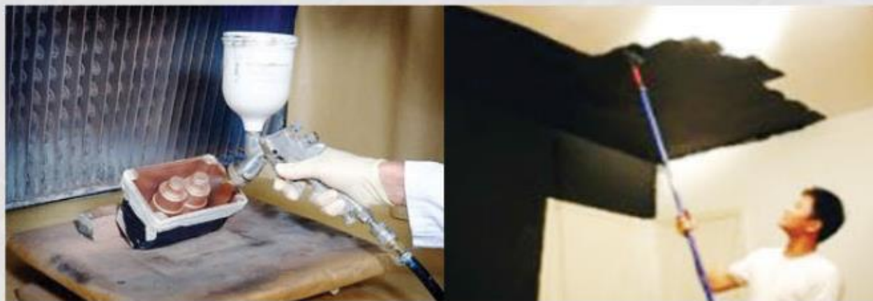
شکل ۶. اعمال پوشش های حفاظت الکترومغناطیسی به صورت رنگ یا اسپری کردن بر روی سطوح مورد نظر
