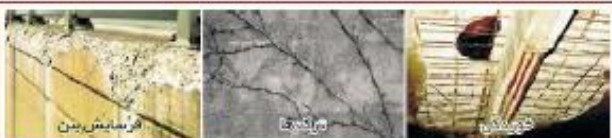
شکل ۱. نمونه‌های از بروز مشکلات در مصالح ساختمانی به دلیل وجود آب و رطوبت
