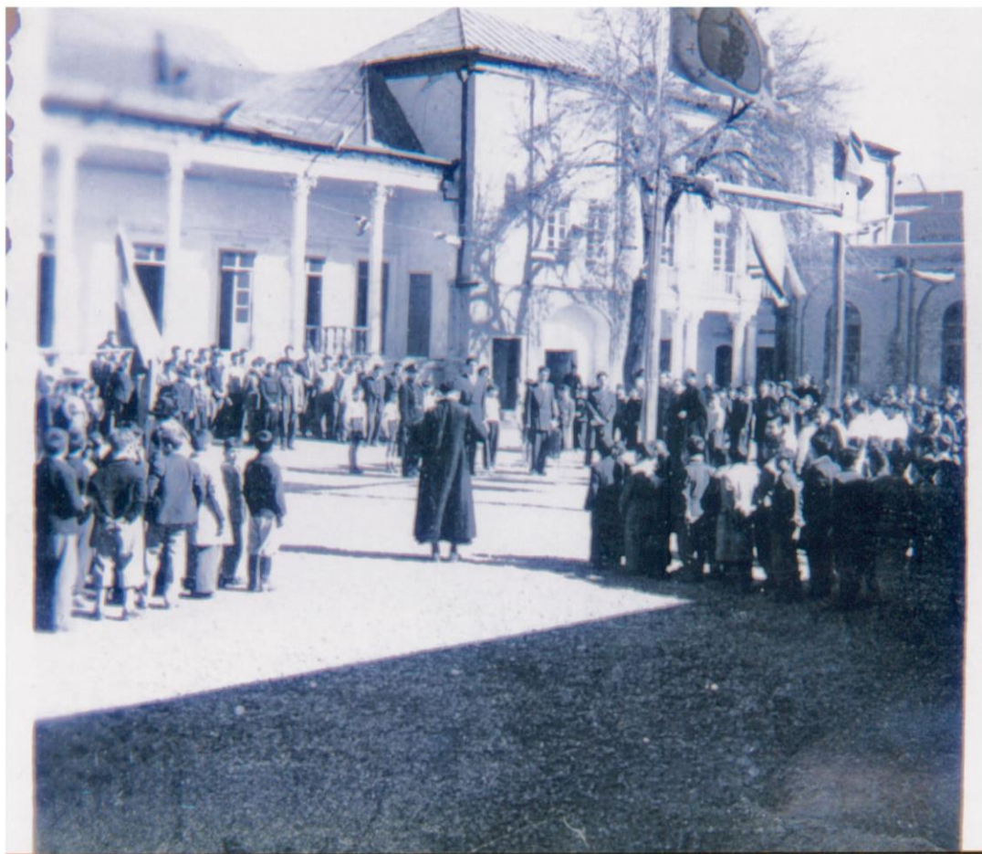
قسمت ۳ طبقه ضلع شمالی، شاهنشین و اطاق ۸ دری پذیرایی. شاهنشین تخریب شد.
