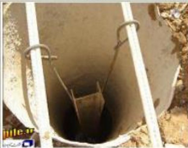
نصب پروفیل در جاه
