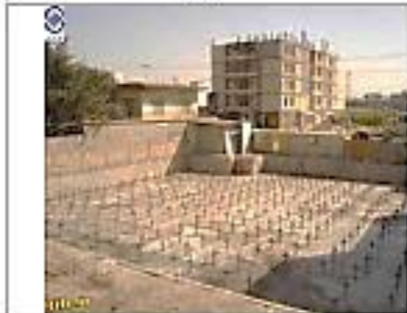
تعلیم از اجرای میکروپایل در زیر فونداسیون
