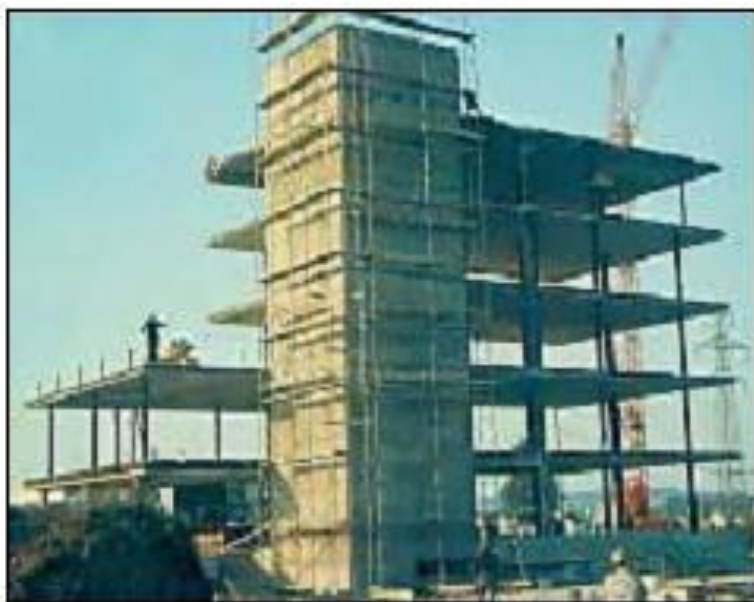
شکل ۳-۶- فاصله زیاد بین مرکز جرم و مرکز سختی و خرابی ناشی از ایجاد پیچش
