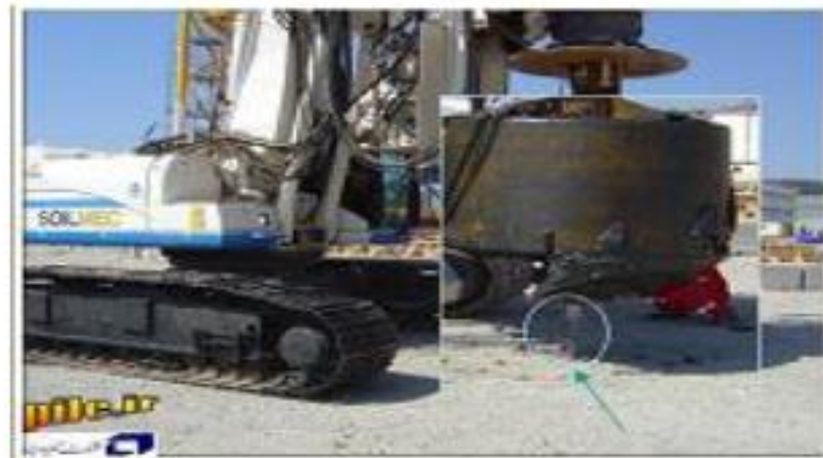
تراز کردن مته حفاری با محل شمع
