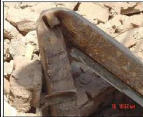
شکل ۱۹-۵-۲- نمونه ای از خرابی ستون های فولادی
