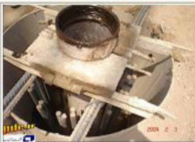
نگه داشتن ترمی در دهانه چاه جهت نصب قیف
