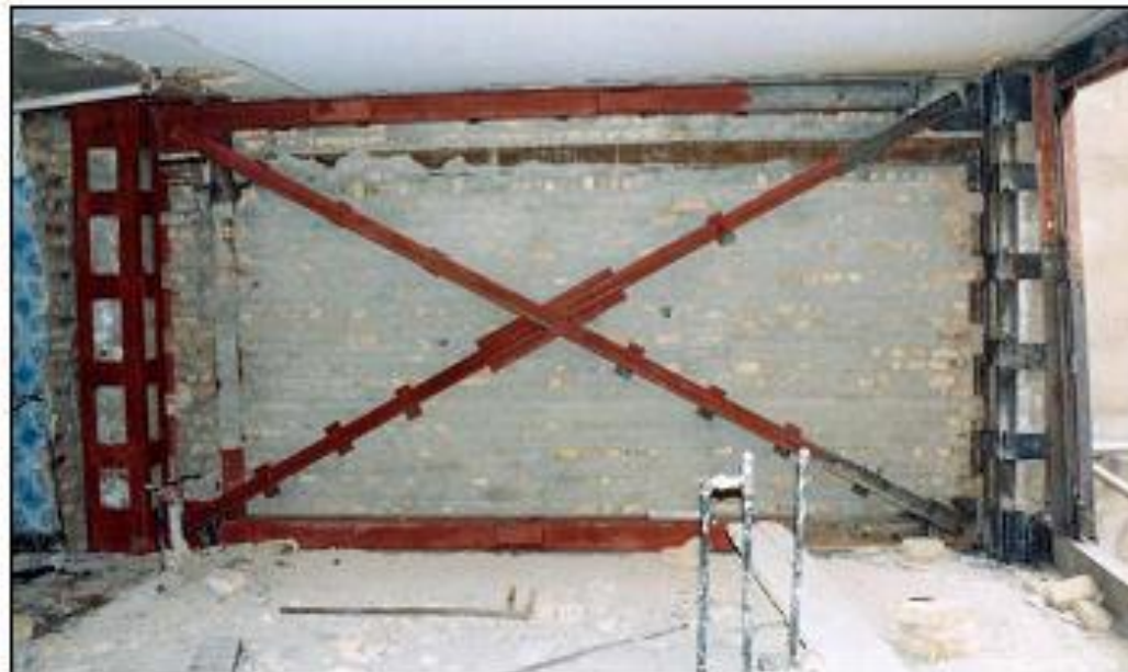
شکل ۴-۵- بهسازی قاب‌های موجود بوسیله مهاربندهای همگرا
