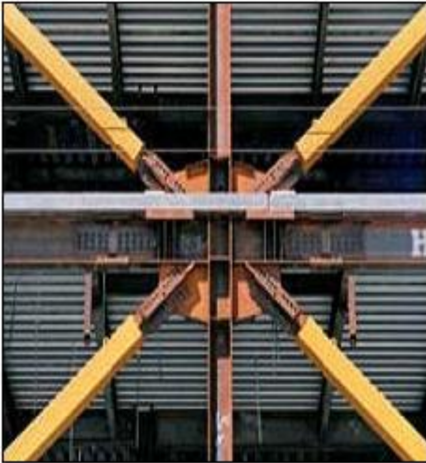
شکل ۴-۱۹- نمونه‌هایی از مهاربند ضد گمانش BRBF
