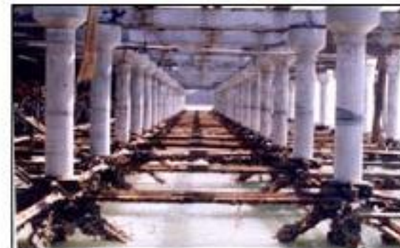
شکل ۲-۵-۲۳- بهسازی ستون‌های با خوردگی شدید با روکش بتنی
