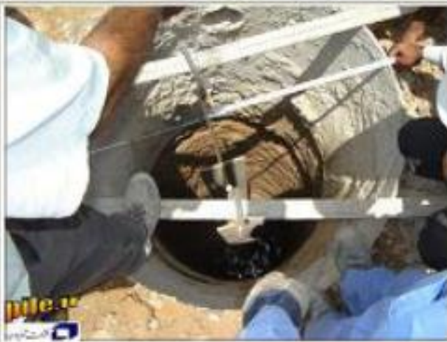
ساقول کردن پروفیل برای قرار گرفتن در مرکز شمع
