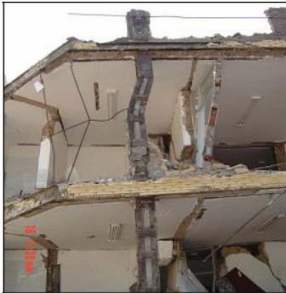
شکل ۱۹-۵-۲- نمونه ای از خرابی ستون های فولادی
