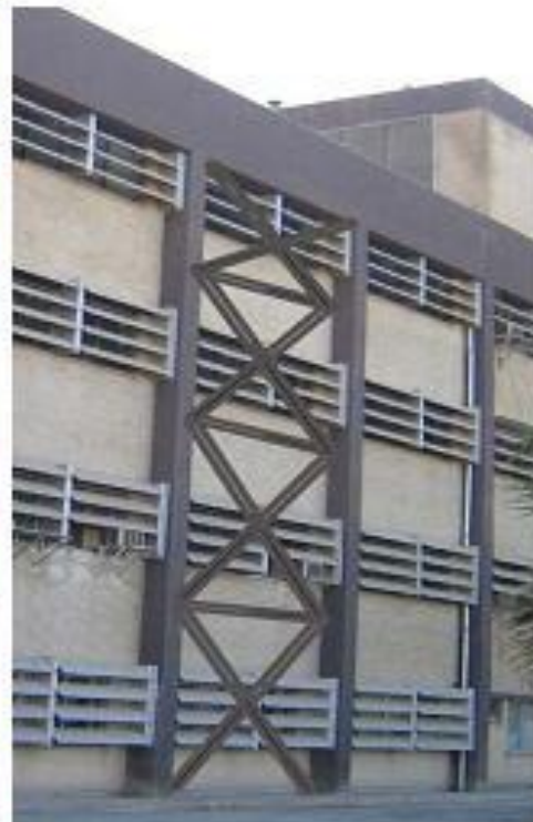
شکل ۳-۴- استفاده از مهاربندها بصورت نمایان در ساختمان‌ها
