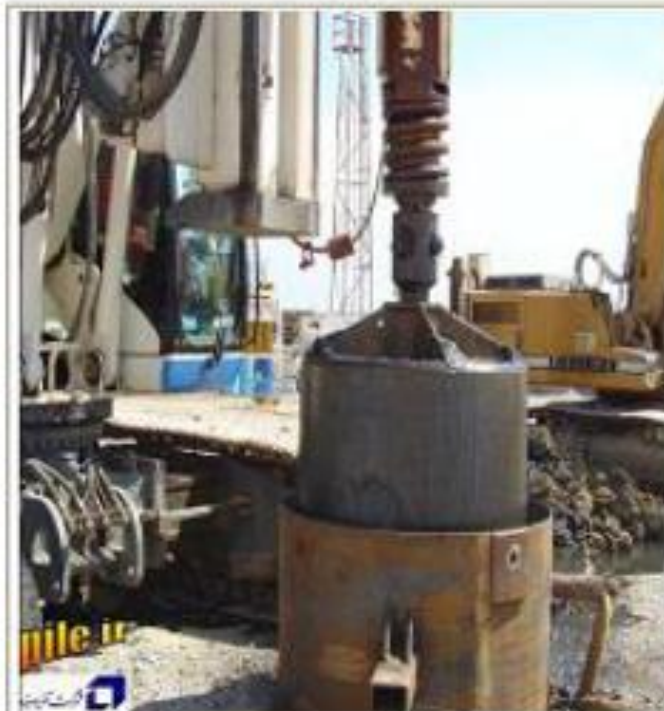
ادامه حفاری از درون کسینگ
