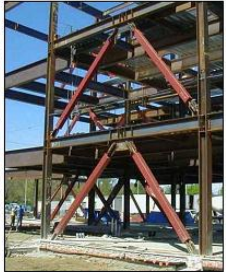
شکل ۴-۱۹- نمونه‌هایی از مهاربند ضد گمانش BRBF
