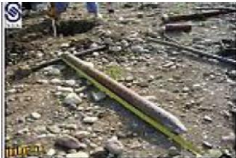
لوله نوک تیز میکروپایل جهت شروع لوله کوبی
