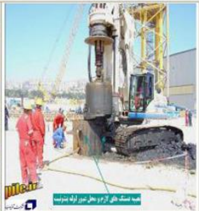
تعبیه دستگ و محل عبور لوله بنتونیت
