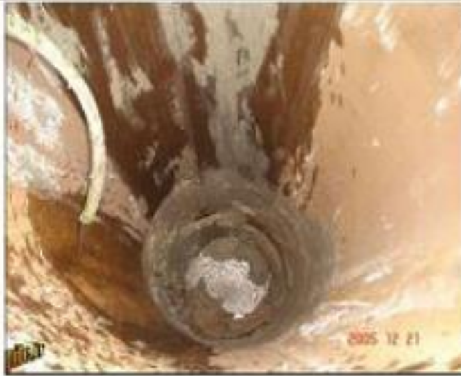
قرارگیری کیسینگ در دهانه شمع
