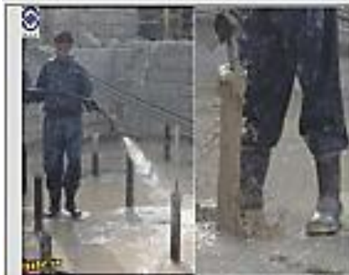
همچنین آب به درون لوله میکروپایل جهت خروج گل و لای درون آن
