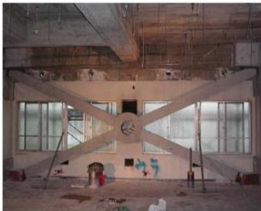
شکل ۴-۲۳- نمونه‌ای از مهاربند بتنی پیش‌تنیده و پیش‌ساخته
