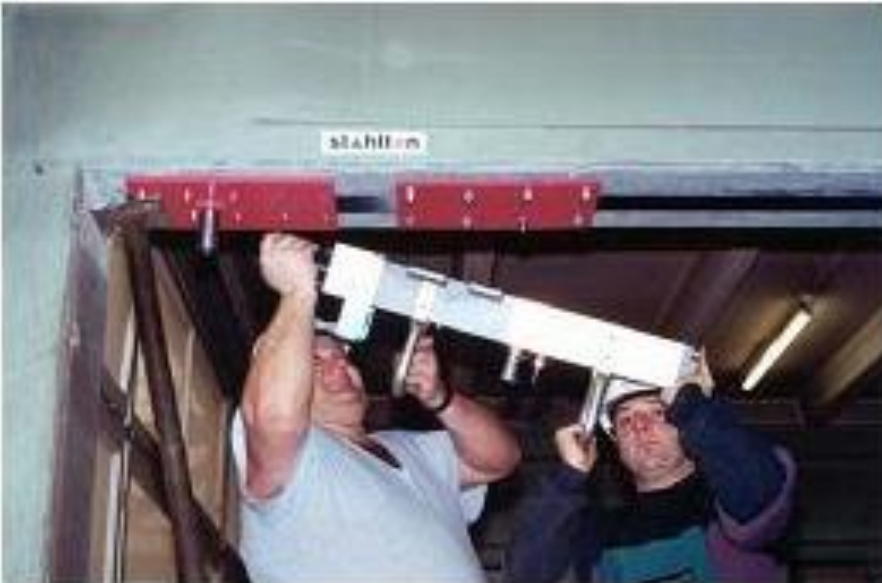
شکل ۲-۴-۱۷- روش پیش تنیدگی در صفحه FRP
