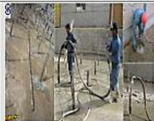
جاگذاری پکر جهت تزریق دوشاب به درون لوله
