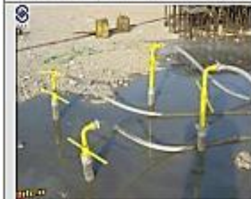
تزریق تحت فشار دوشاب به درون لوله میکروپایل
