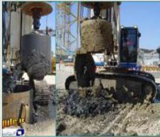
تخلیه باکت بعد از هر بار پر شدن
