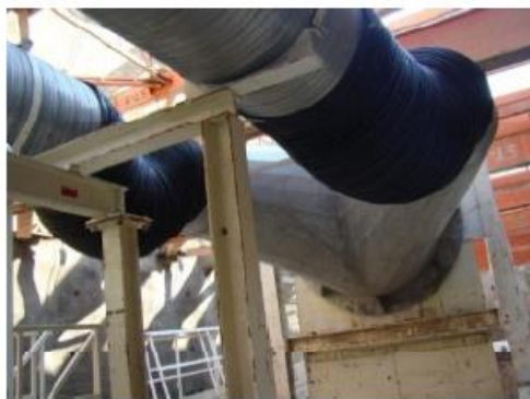
ب- صفحه اتصال دوراهی و لوله‌های انعطاف‌پذیر
