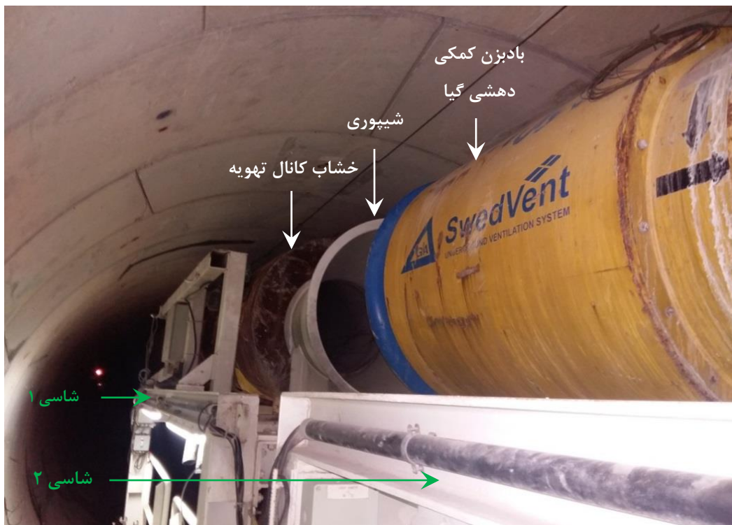
شکل ۲-۴- نمایی از خشاب کانال تهویه و شیپوری بر روی شاسی ۱ و بادبزنی دهشی کمکی بر روی شاسی ۲
