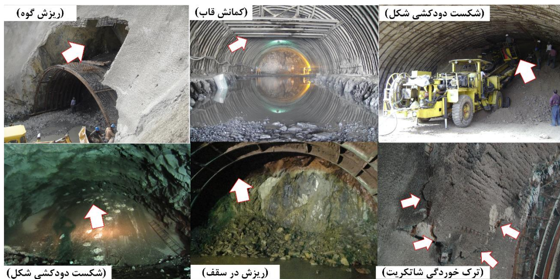
شکل ۴-۲۳. ریزش های به وقوع پیوسته در تونل های مورد مطالعه
