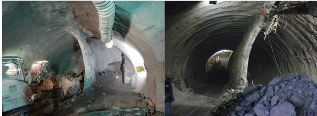
شکل ۲-۹. روش دیافراگم مرکزی (مرکادو و همکاران ۱ ، ۲۰۰۴)
