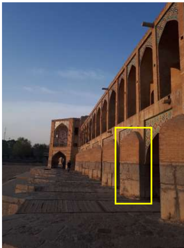
شکل ۴-۱۶: تصویری از نمای غربی پل خواجه. مستطیل زرد رنگ نشان دهنده‌ی یکی از پایه‌های بیرون زده‌ی پل می‌باشد.
