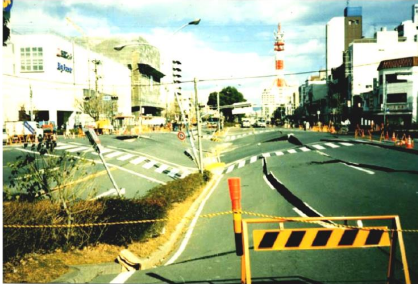
شکل ۲-۲: فرونشست سطح زمین در نتیجه گسیختگی در ایستگاه مترو دایکای (مصطفوی مقدم و آشتیانی، ۱۳۹۱)
