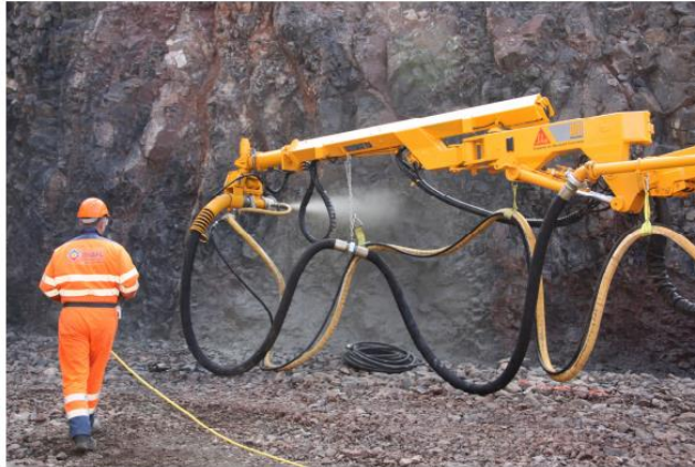
شکل ۵-۱۷-دستگاه شاتکریت پاش (Hjálmarsson, E, H, 2011)
