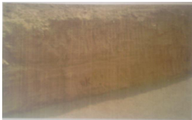
شکل ۸-۲- تصویری از لایه‌های خاک ریزدانه متعلق به سازند C در کانال حفرشده جهت جایگذاری لوله
