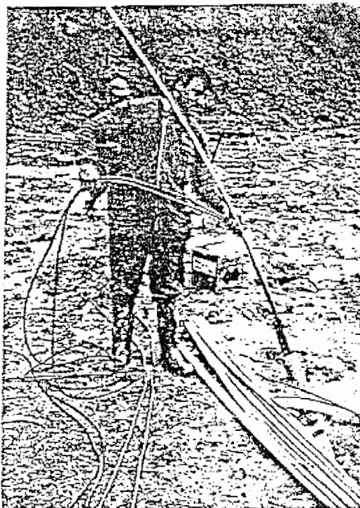
شکل ۷-۲ خرجگذاری با کورتکسهای با خرج مرکزی بالا در چالها برای آتشباری کنترل شده [۵]
