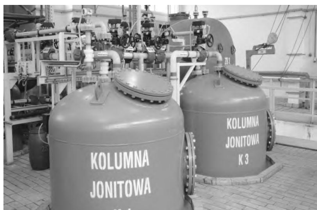
شکل ۲-۲ ستون‌های تبادل یونی به کار گرفته شده در تکنولوژی لهستانی (Chmielarz et al., ۲۰۱۰)
