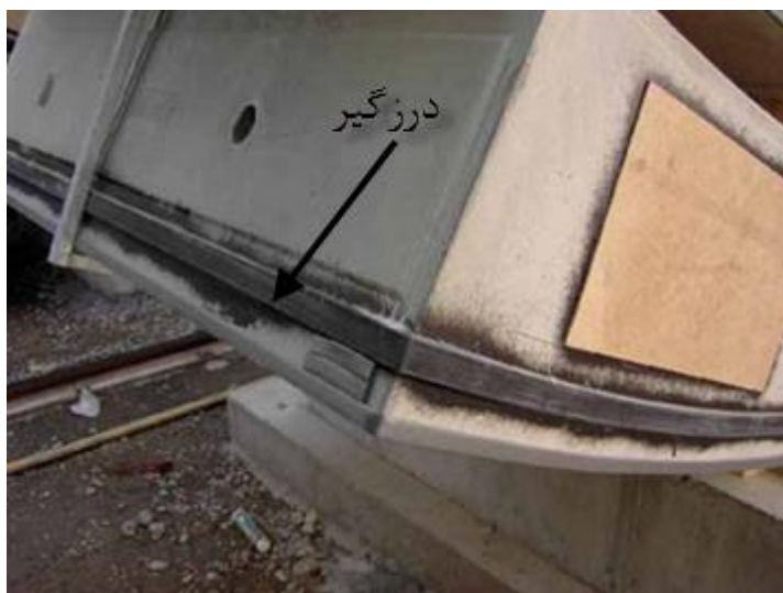
شکل ۶-۳- پوشش سگمندی همراه با درزگیر (Wittke and Druffel, 2006)
