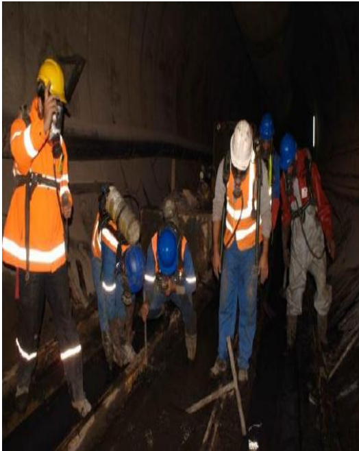
دشواری عملیات اجرایی به دلیل تراوش شدید آب و نفوذگاز در تونل
