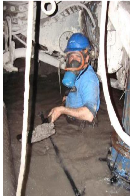
دشواری عملیات اجرایی به دلیل تراوش شدید آب و نفوذگاز در تونل
