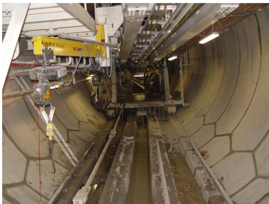
پوشش سگمتی هگزاگونال مورد استفاده در تونل
