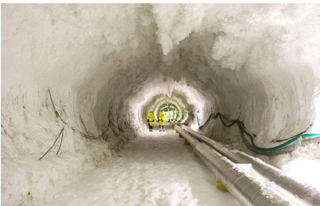
شکل ۶-۸- به کارگیری روش انجماد زمین در حفر تونل هندس‌اس (Wallentinus and Paivo, 2001)
