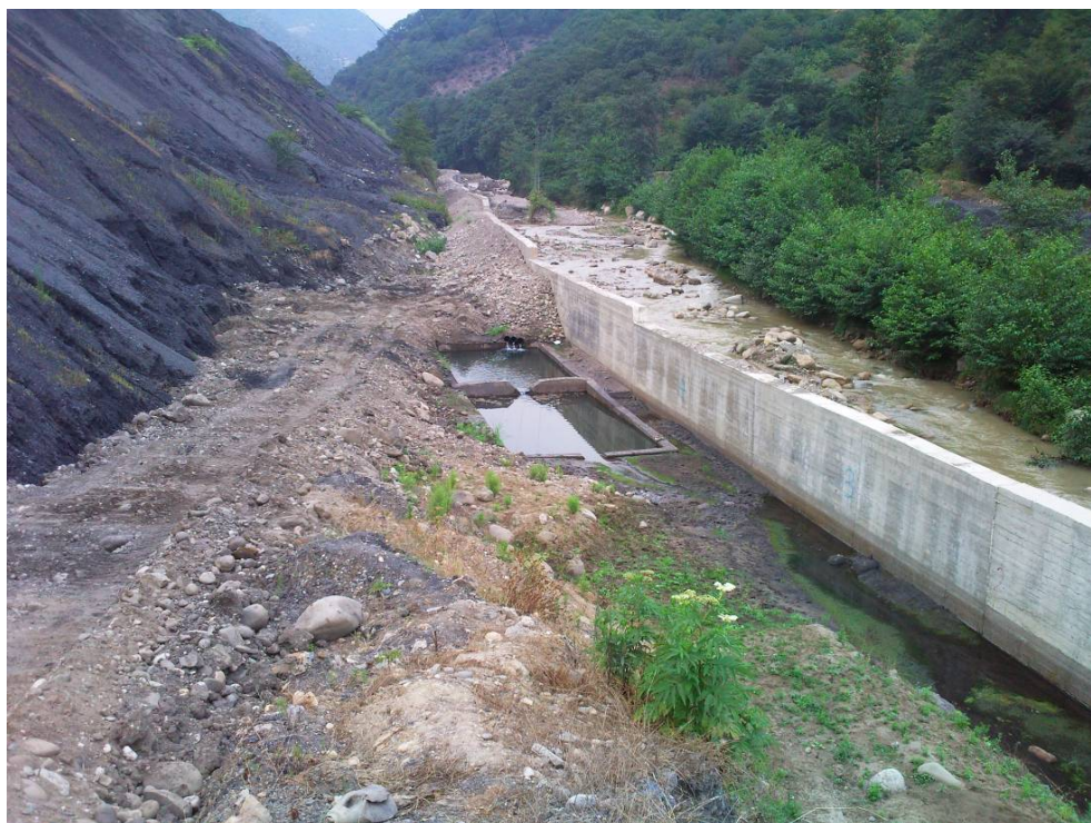
شکل ۳-۶. احداث دیوار بتنی جهت جلوگیری از ورود مواد شیمیایی محلول و زهاب تولیدی به رودخانه دلیلیم.
