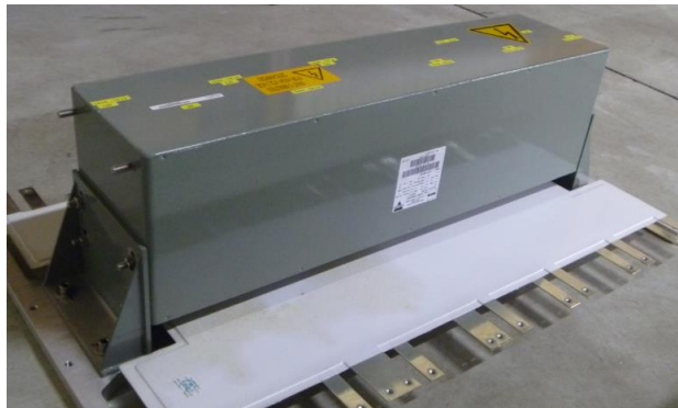
شکل ۴-A - خازن dc-link در تجهیز اینورتر ترکشن
