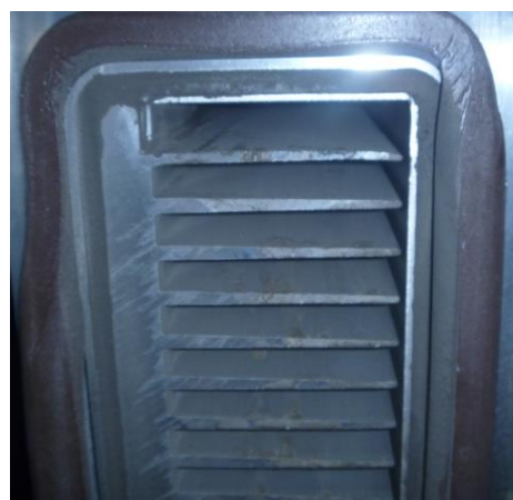
شکل A-۲۰- دور دریچه محفظه هدسینک، نوار عایقی جهت جلوگیری از ورود گردو غبار وجود دارد.
