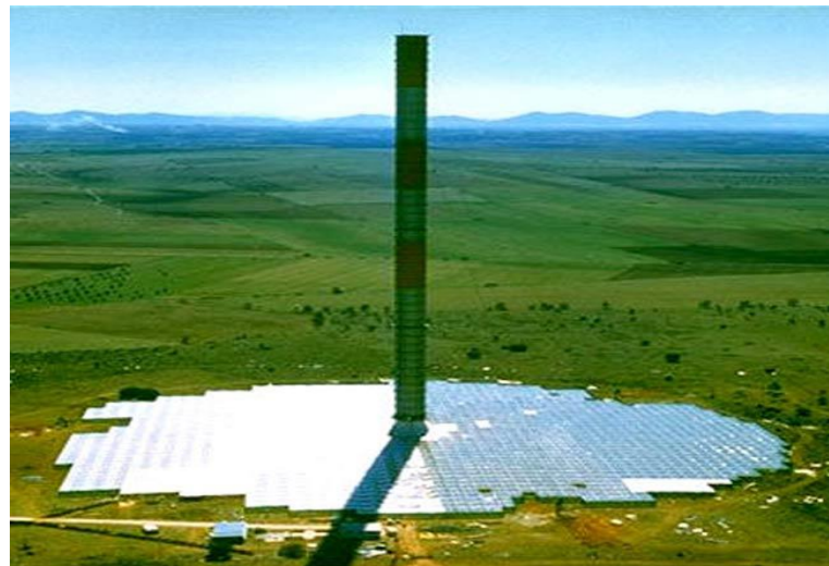
شکل ۳-۷: نیروگاههای حرارتی از نوع دودکش خورشیدی [۲۵]
