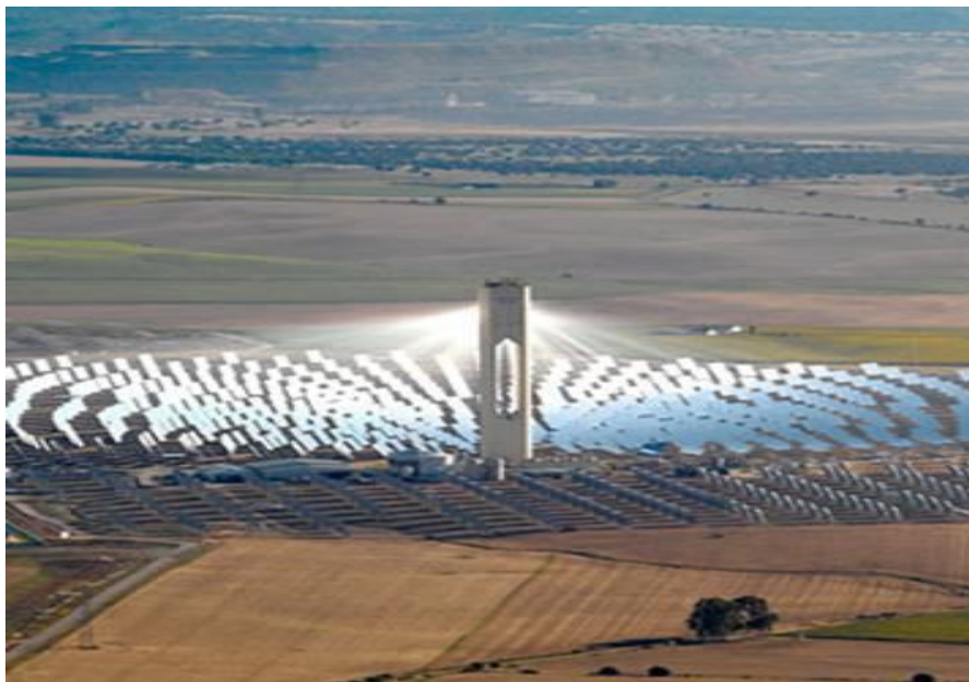
شکل ۳-۵: نیروگاه‌های حرارتی از نوع دریافت کننده مرکزی [۲۵]
