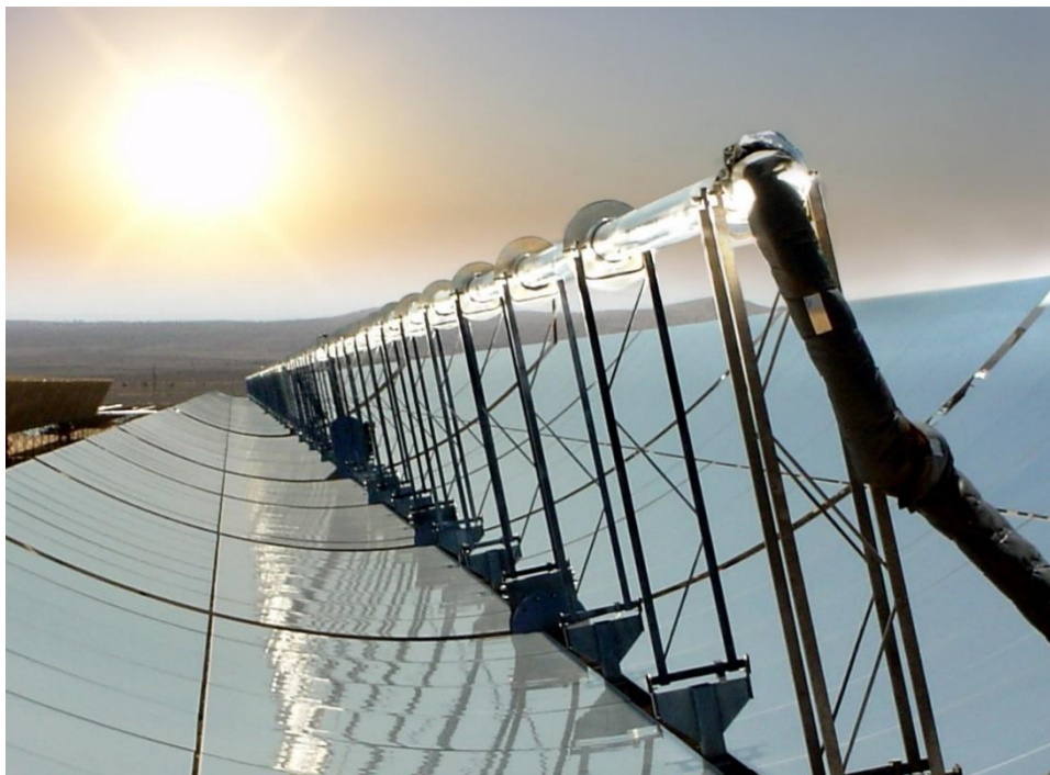
شکل ۳-۴: نیروگاههای حرارتی خورشیدی از نوع سهموی خطی [۲۵]
