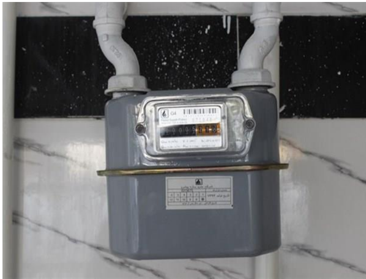
شکل (۴-۱) : نمونه‌ای از کنتور گاز مصرف خانگی
