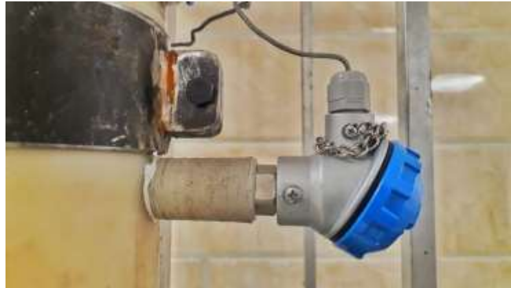
شکل ۷-۴: سنسور اندازه‌گیری دمای سیال از نوع PT100 پراب دار
